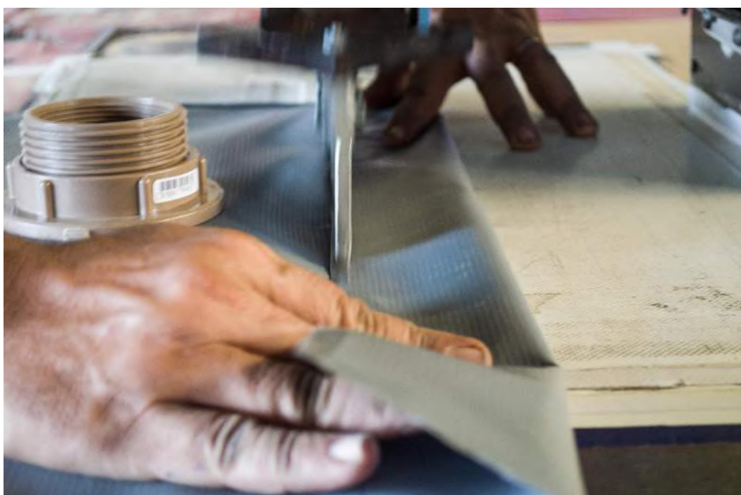
Figura 157: Fazendo a lateral para passagem do tubo. Fonte: elaboração própria.
