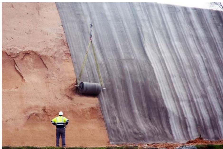
Figura 73: Concrete canvas para encostas Fonte: < https://www.concretecanvas.com >
