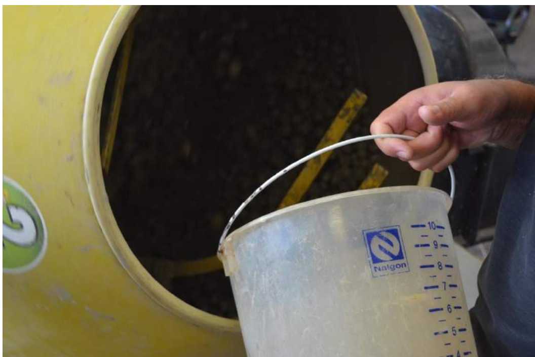
Figura 146: Acréscimo de água na mistura. Fonte: elaboração própria.
