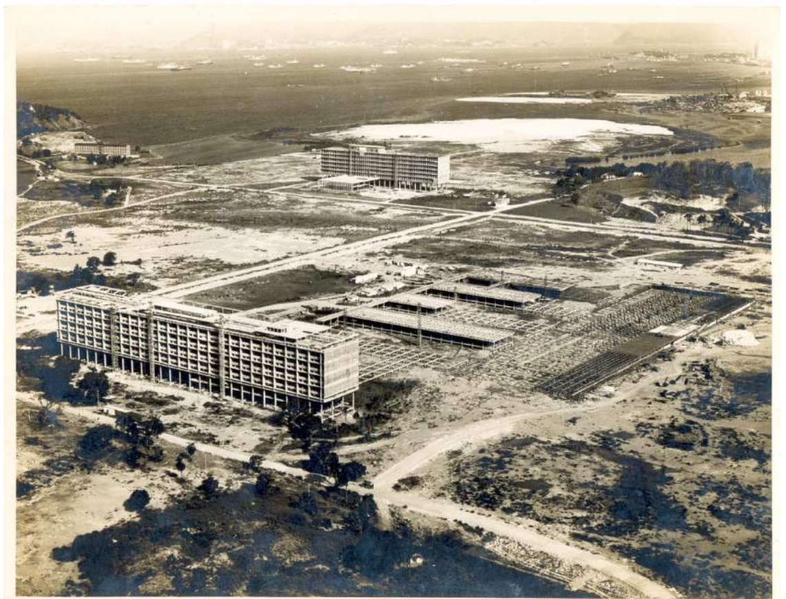
Figura 1: Construção das Unidades – Centro de Tecnologia e Faculdade de Arquitetura e Urbanismo, 1961 Fonte: < http://arquguia.com/obra/edificio-reitoria-ufrj >
