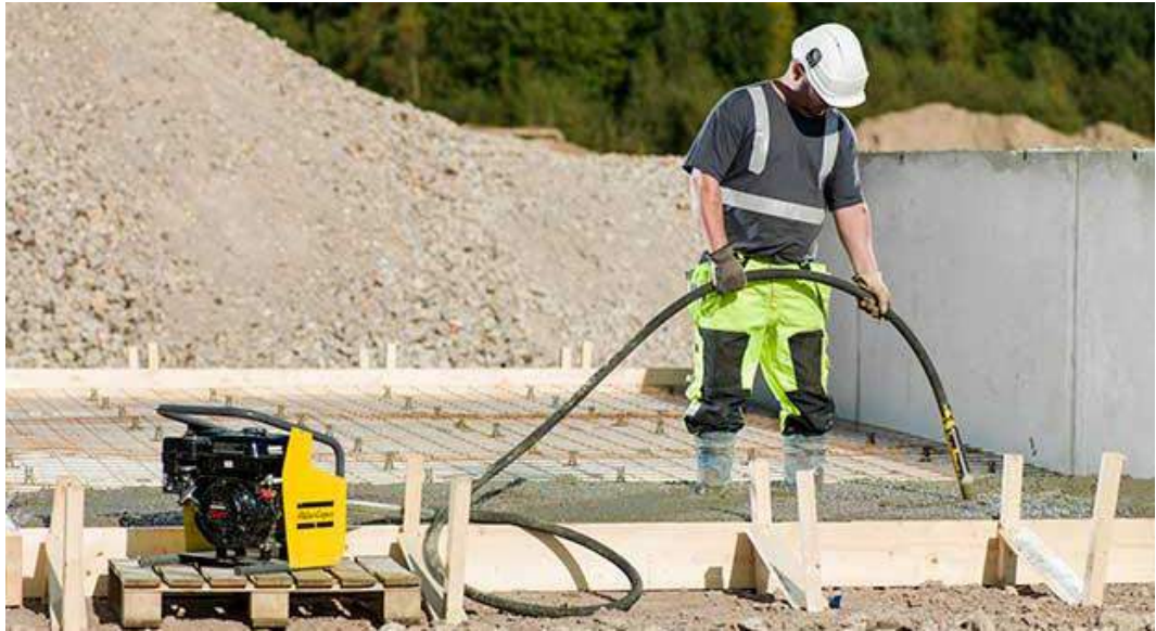
Figura 129: Adensamento do concreto com vibrador.
