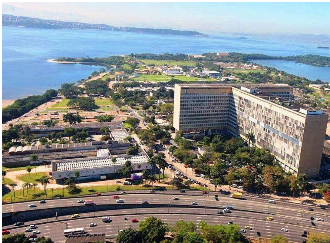
Figura 2: Vista aérea do Hospital Universitário, 2016.
