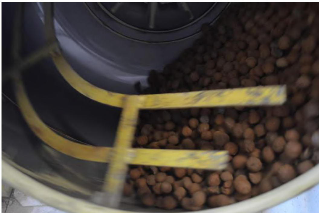
Figura 142: Argila expandida na betoneira. Fonte: elaboração própria.
