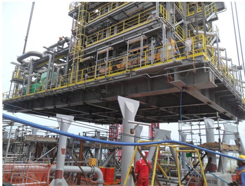
Figura 25 - Detalhe de um dos apoios do módulo com o suporte sobre o convés do FPSO
