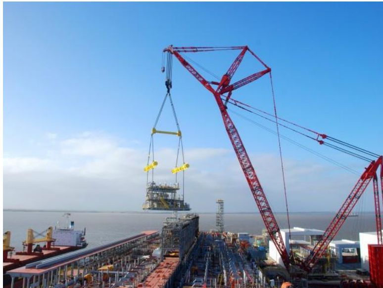
Figura 18 - Içamento de um módulo para o convés da P-58 no estaleiro Rio Grande
