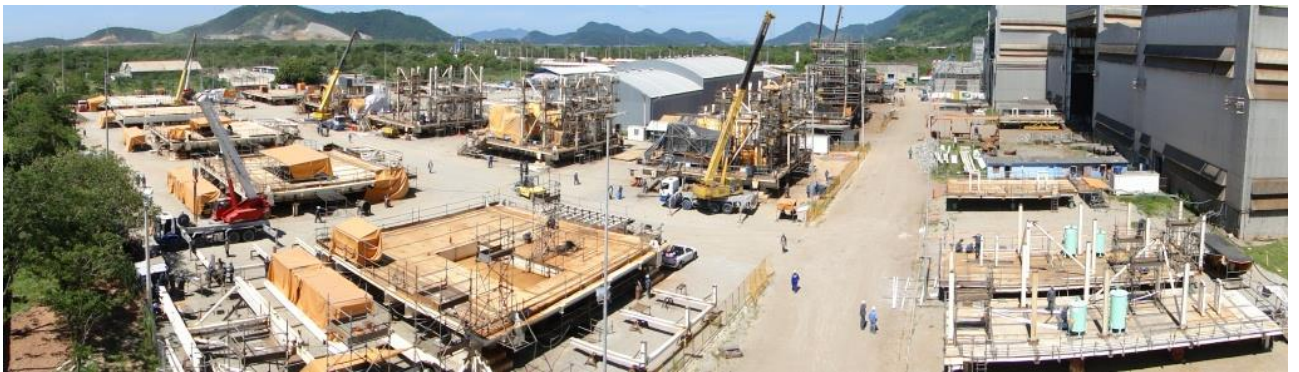
Figura 9 - Montagem de alguns módulos no canteiro de obras
