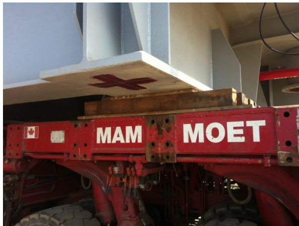
Figura 13 - Apoio entre base do Módulo e boogie
