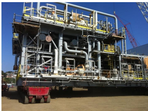
Figura 15 - Transporte de módulo sobre Boogies –Operação de Load Out
