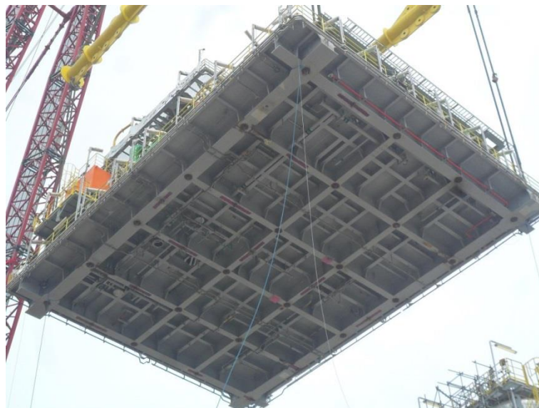
Figura 21 - Vista inferior do módulo e os elementos componentes da base
