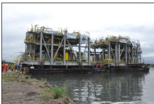
Figura 16 - Módulos no convés da Balsa – Operação de Load Out
