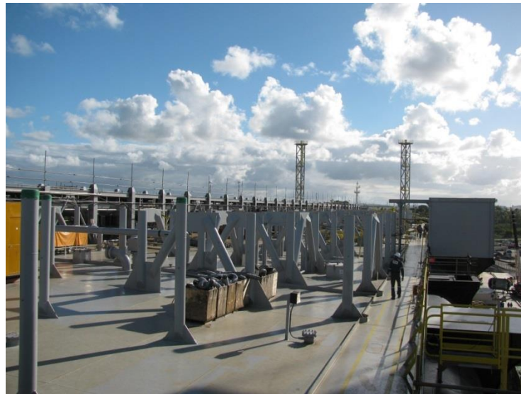
Figura 22 - Suportes do módulo sobre o convés do FPSO
