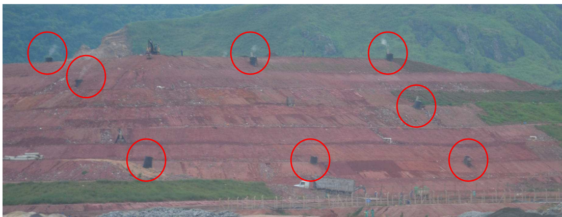
Figura 24: Emissão direta do biogás, através de poços sem tratamento produzido pela CTR de Seropédica. (Foto: Mariana Costa, janeiro 2013).
