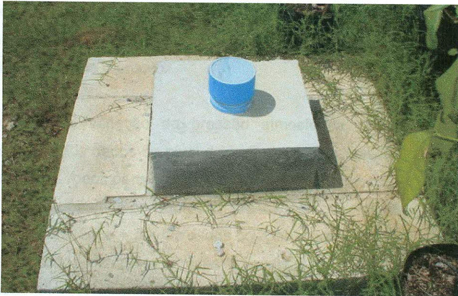
Figura 9 – Poço de monitoramento construído com trado manual.
