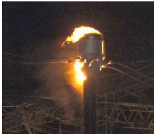
Figura 2.7 - Exemplo do efeito de uma falha interna em um TC de alta tensão Fonte: Acervo do CEPEL
