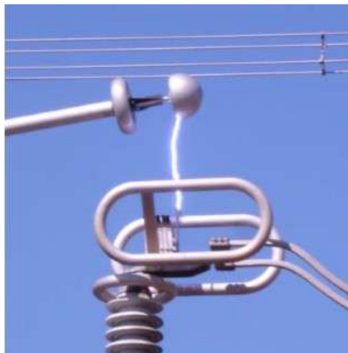
Figura 2.8 - Arco elétrico formado entre os polos de uma chave seccionadora durante uma manobra [17]
