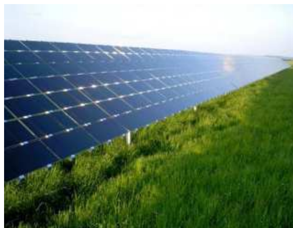
Figura 4.18 – Módulo de CdTe
