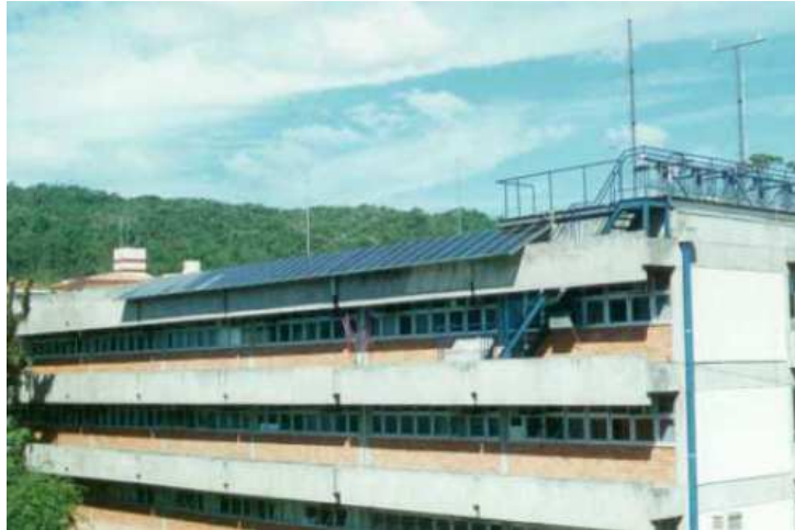
Figura 2.6 - Sistema fotovoltaico integrado ao envoltório da edificação do Departamento de Engenharia Mecânica da UFSC
