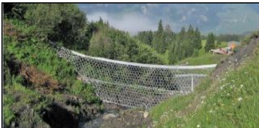
Figura 4.7: Barreira flexível (Geobruigg, 2012).
