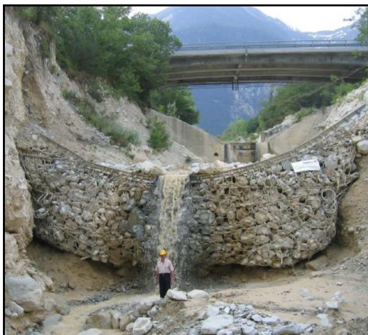
Figura 4.8: barreira flexível construída para testes em Illgraben (McArdell, 2012).
