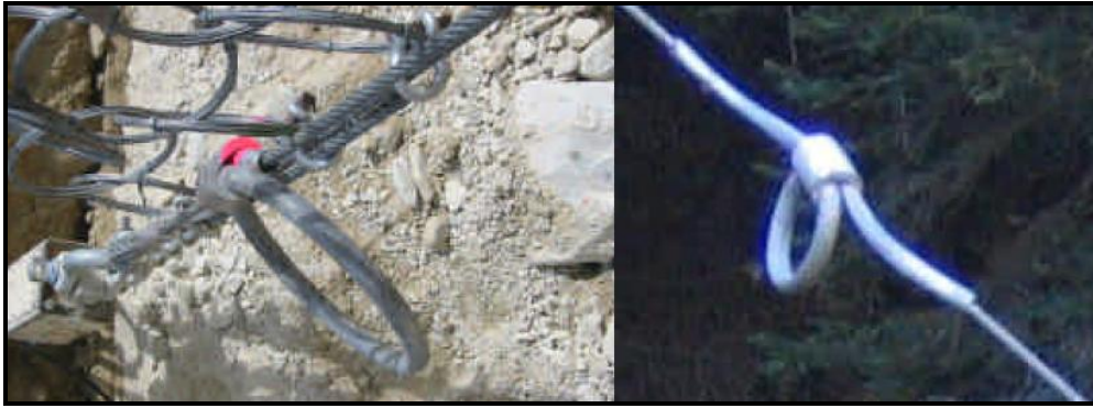
Figura 4.10: Anéis de freio (Wenderler, 2006)
