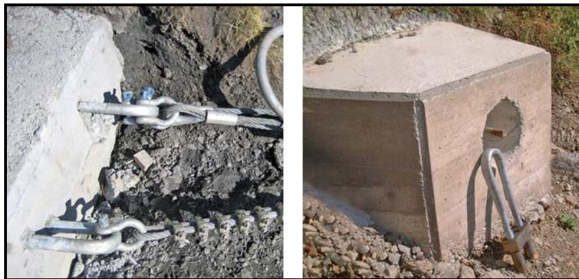
Figura 4.11: Ancoragens (Geobrugg, 2012).
