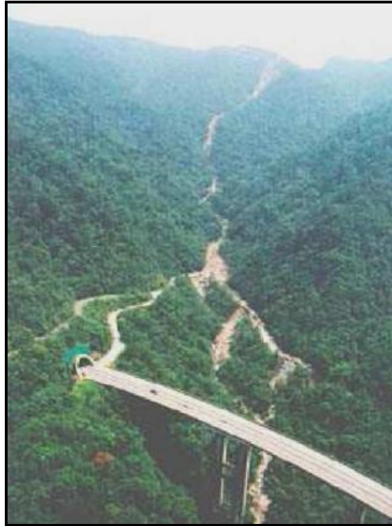
Figura 2.6: Fluxo de detritos na via Anchieta em 1999 (Polanco, 2010).
