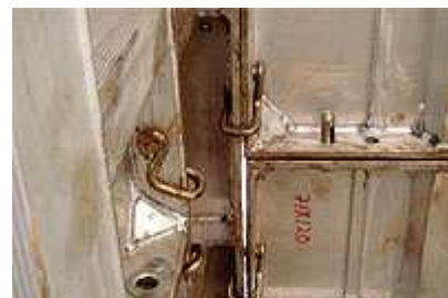
Figura : Cantoneira conectada através de grapas.
