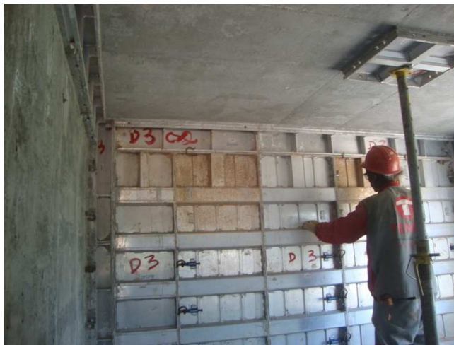
Figura : Operação de desforma. Fonte: Autor, 2010
