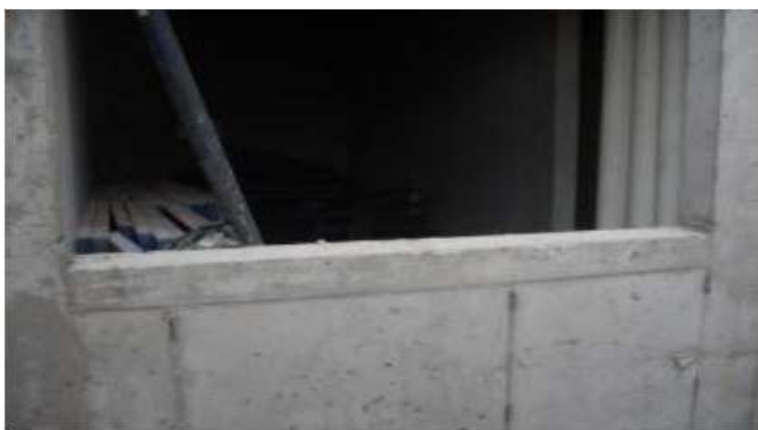
Figura : Bom acabamento da superfície de concreto, friso bem feito e requadro de janela bem executado
