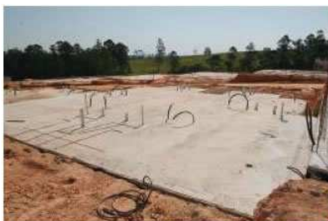
Figura : Radier. Fonte: Comunidade da Construção, 2012
