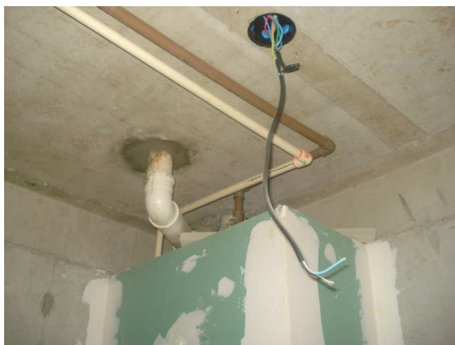
Figura : Fechamento com da prumada com drywall . Fonte: Autor, 2010
