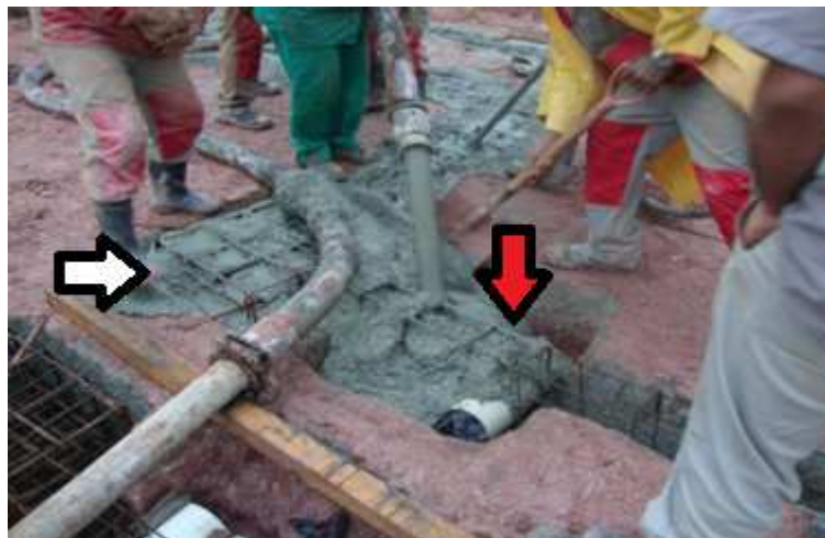
Figura : Vigas-Baldrame. Fonte: Autor, 2010
