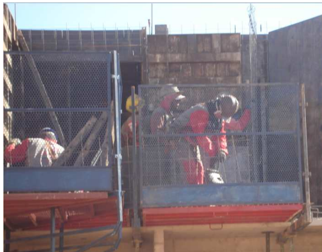
Figura : Plataforma de montagem. Fonte: Autor, 2010
