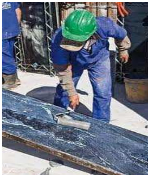
Figura : Peça com óleo desmoldante. Fonte: VENTURINI, 2011
