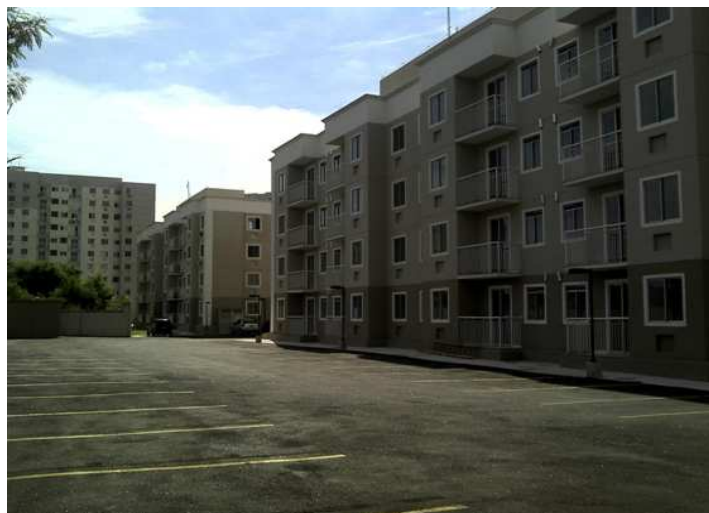
Figura : Bloco 01 concluído. Fonte: Autor, 2010
