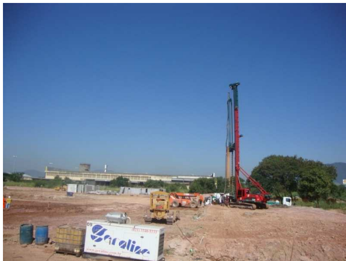
Figura : Execução das estacas do bloco 26. Fonte: Arquivo Interno, 2010
