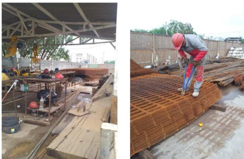
Figura : Central de corte e dobra. Fonte: Autor, 2010
