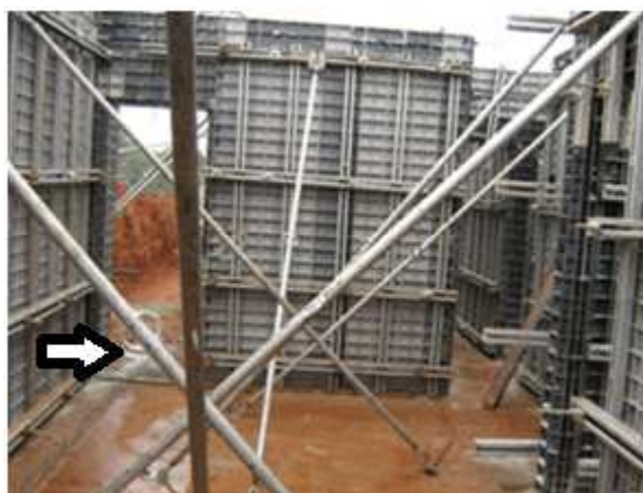
Figura : Tensor de parede travando o sistema de forma. Fonte : http://papodeobra.blogspot.com.br/2008_09_01_archive.html , 2012
