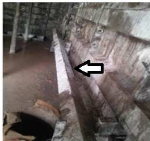
Figura : Alinhadores horizontais e perfil alinhador. Fonte : Construtora Tenda – Acervo de Obras, 2011
