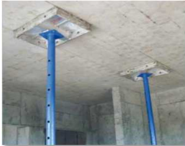
Figura : Escoramento remanescente. Fonte: E.T. Construtora Tenda S/A
