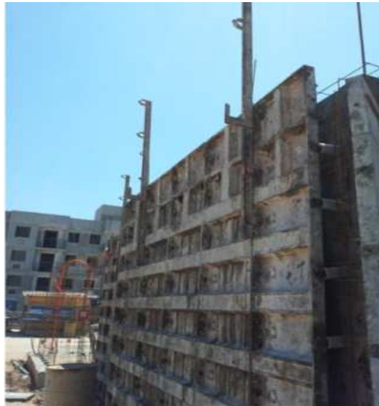
Figura : Alinhador vertical. Fonte: Construtora Tenda – Acervo de Obras, 2011
