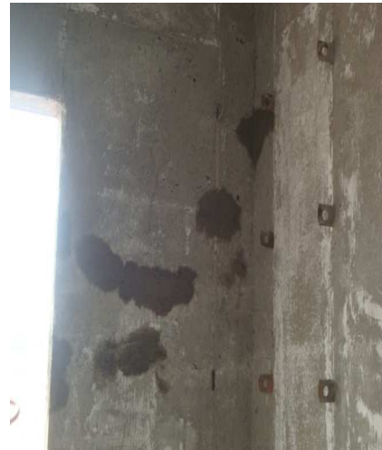
Figura : Regularização da superfície de concreto. Fonte: Autor, 2010
