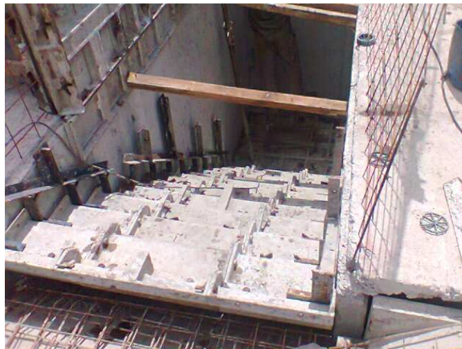
Figura : Escada montada. Fonte: Autor, 2010
