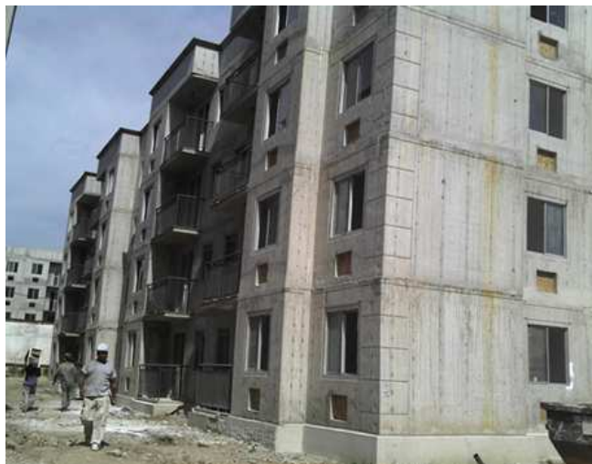
Figura : Estrutura do bloco 01 pronta. Fonte, Autor 2010
