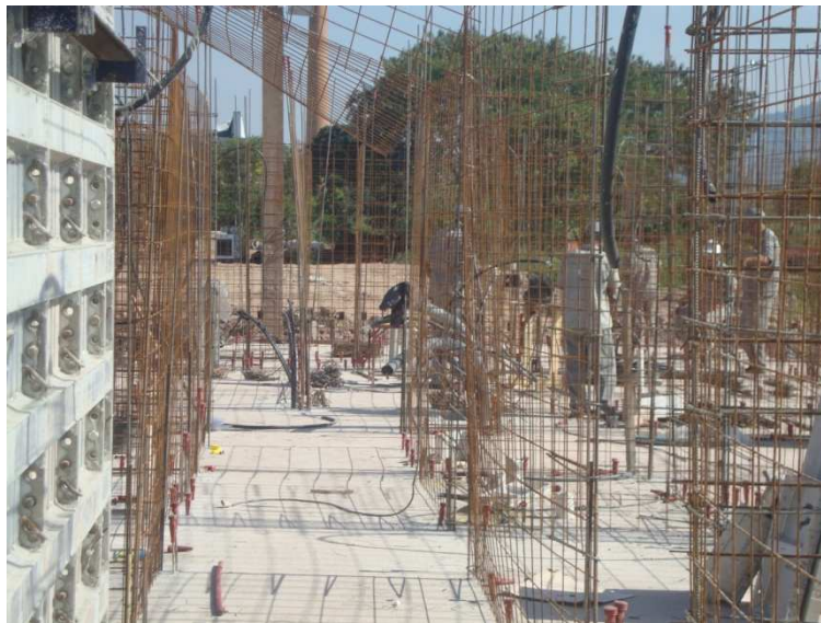
Figura : Armação de uma etapa de concretagem. Fonte: Autor, 2010
