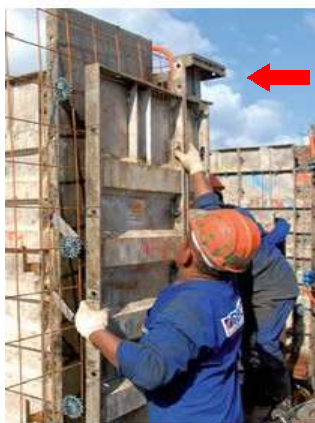
Figura : União parede-laje.
