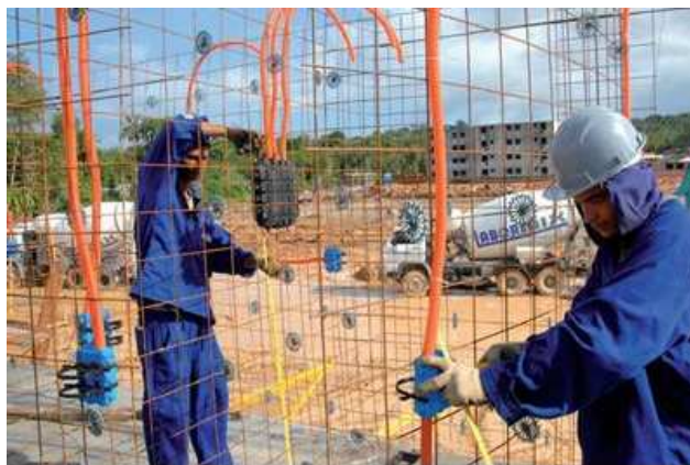
Figura : Instalação de eletrodutos flexíveis e caixas de passagens.
