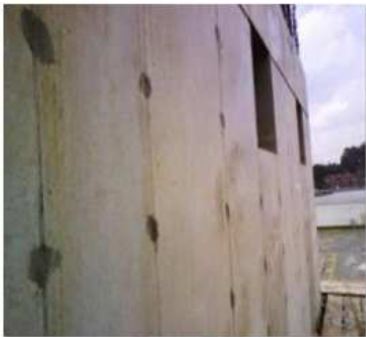
Figura : : Superfície bem adensada, com as entranças das corbatas já estucadas. Fonte: Construtora Tenda – Acervo de Obra.
