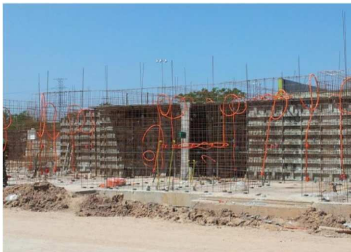
Figura : Condutores flexíveis e caixas de passagens instalados nas telas das paredes. Fonte: Autor, 2010
