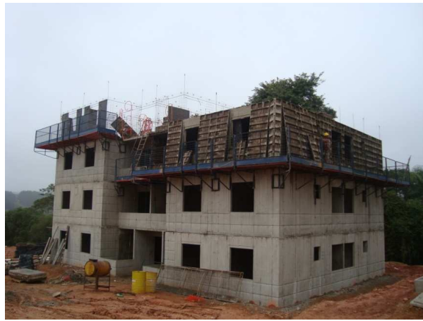
Figura : Andaime em balanço. Fonte: Construtora Tenda – Acervo de Obra
