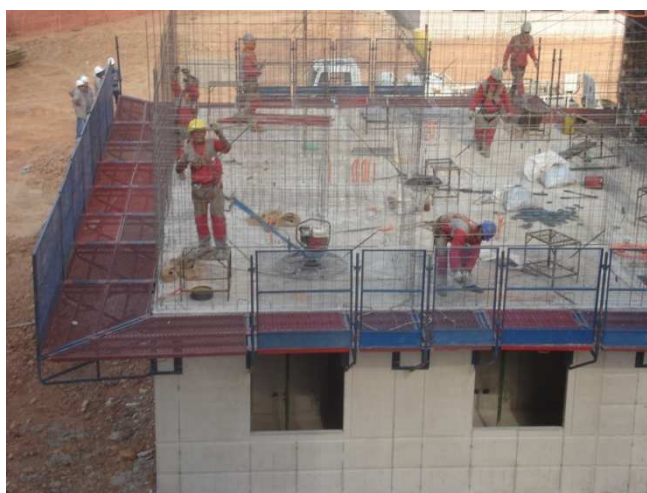
Figura : Armação de paredes. Fonte: Contrutora Tenda – Arcervo de Obra, 2011
