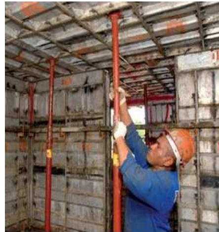
Figura : Instalação de escora metálica.
