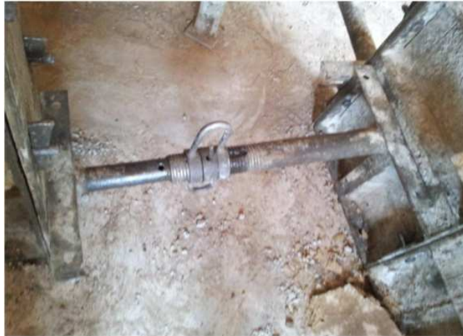
Figura : Tensor expansível de vão de porta Fonte: Construtora Tenda – Acervo de Obra, 2009
