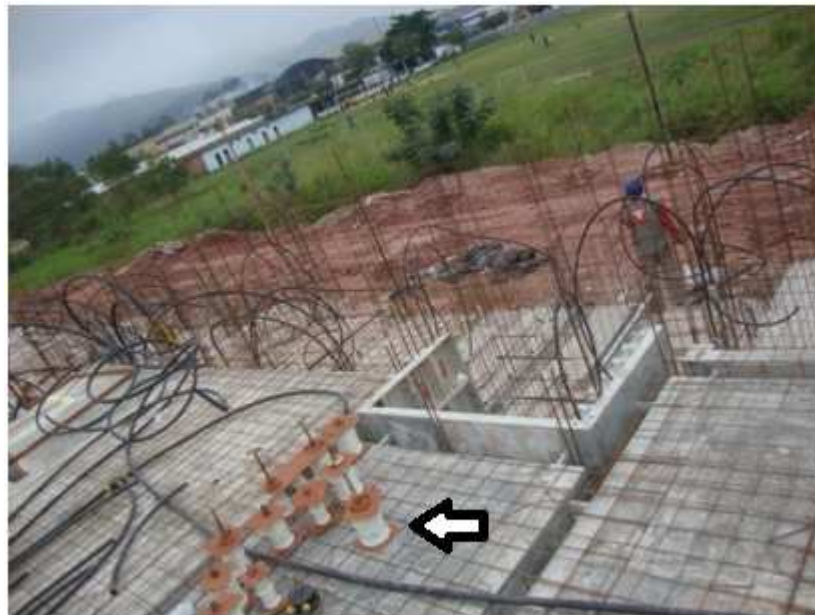
Figura : Instalação elétrica executada, faltando apenas posicionar as esperas do esgoto Fonte: Autor, 2010
