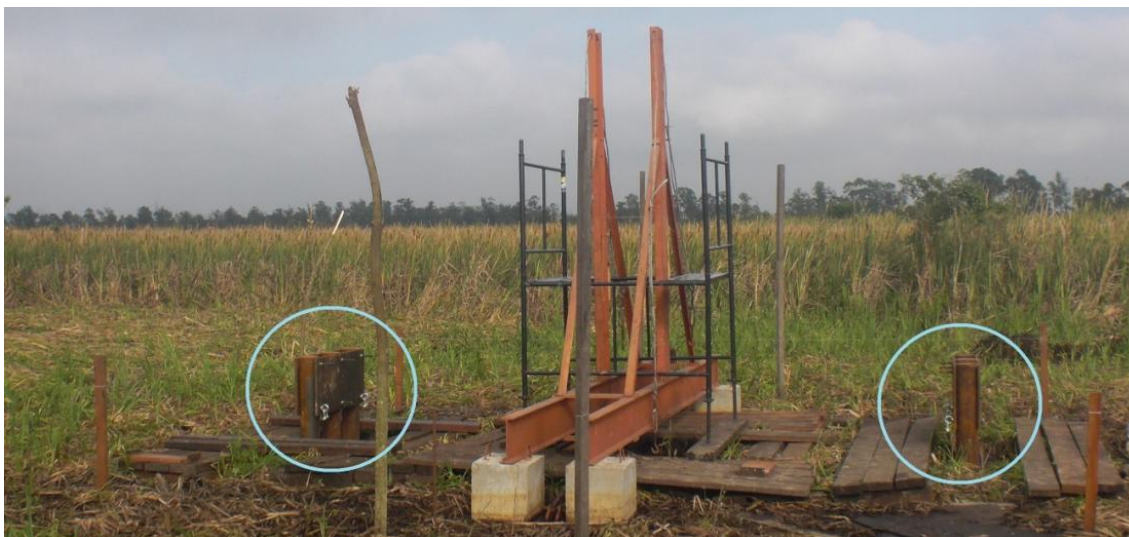
Figura 5.21 – Grupos de estacas de reação
