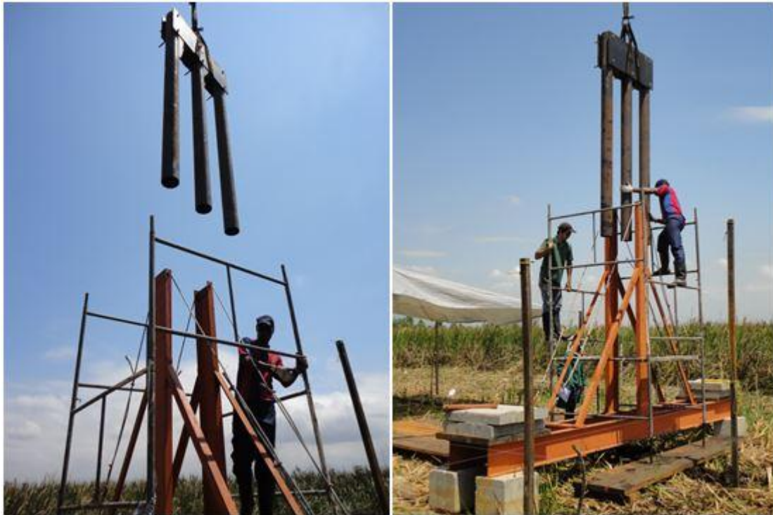
Figura 5.33 – Posicionamento do grupo de estacas com auxílio do caminhão Munck
