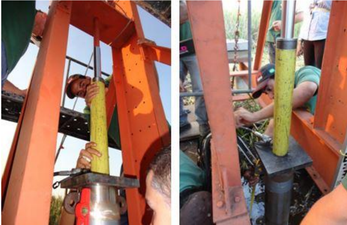
Figura 5.36 – Segunda etapa da cravação, com macaco hidráulico
