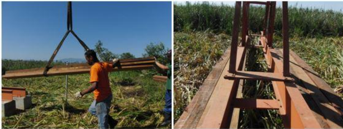
Figura 5.11 – Passarelas auxiliares sendo posicionadas
