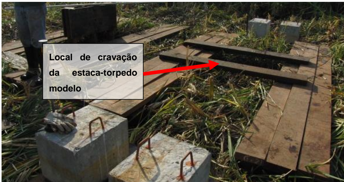
Figura 5.12 – Posicionamento das passarelas auxiliares
