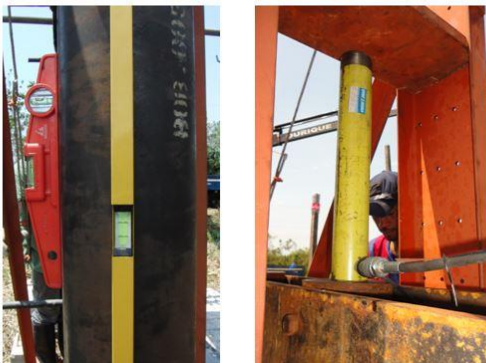
Figura 5.34 – Conferência da verticalidade e cravação com auxílio do macaco hidráulico
