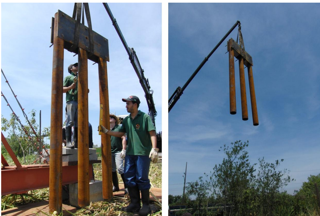
Figura 5.19 – Grupo de estacas de reação
