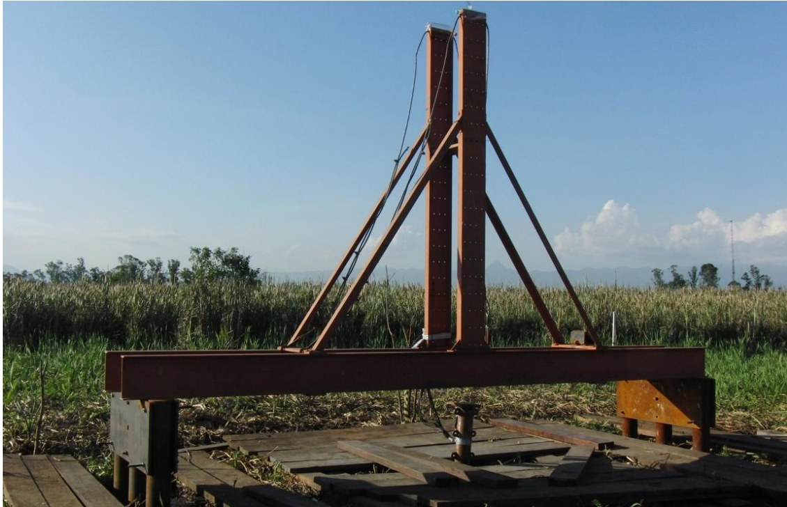
Figura 5.32 – Sistema de cravação após instalação da estaca-torpedo modelo
