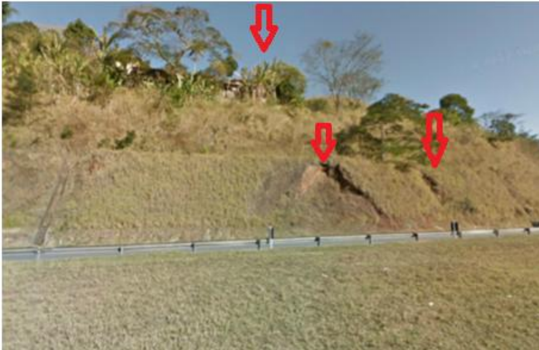
Figura 3-3 - Escorregamentos no Talude em estudo (Autor).
