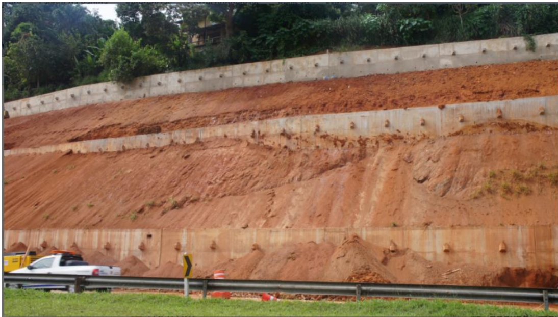
Figura 3-5 - Cortinas Ancoradas, na Rodovia em Estudo (Autor).
