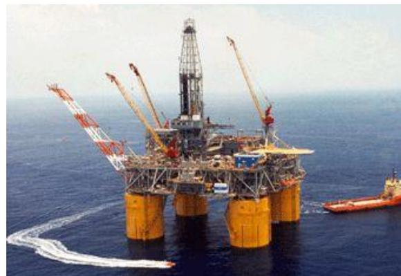
**Figura 2.4 – Ilustração de uma TLP com Ancoragem Vertical.**
