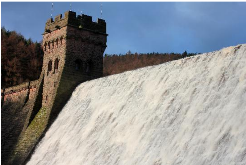
Figura 4: Barragem de concreto projetada para suportar o galgamento, em Derwent – Inglaterra (fonte: www.tripadvisor.com.br ).
