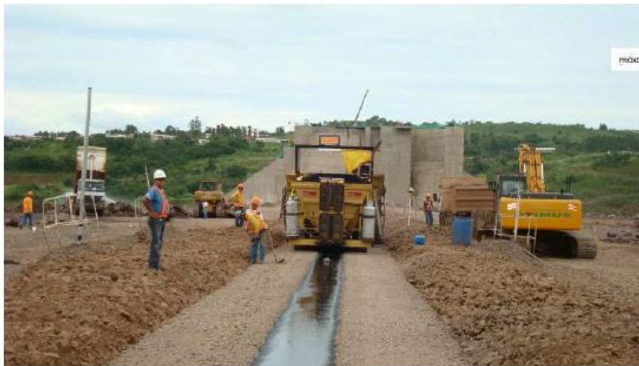
Figura 18: Fase de construção do núcleo asfáltico da Barragem de Foz do Chapecó – Brasil (MENDONÇA, 2012).
