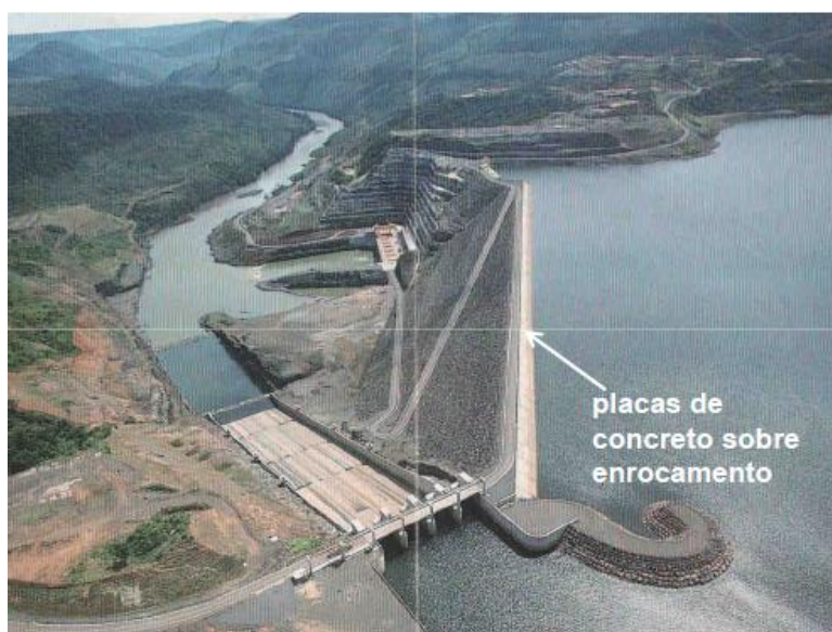
Figura 17: Exemplo de barragem com face de concreto, Barragem de Foz do Areia – PR (MENDONÇA, 2012).
