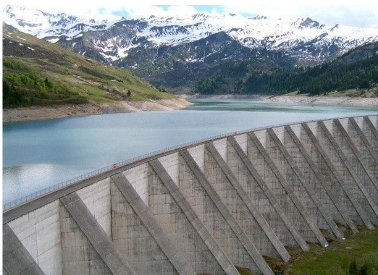
Figura 7: Exemplo de barragem com contraforte em Roselend – França (SAYÃO, 2009).
