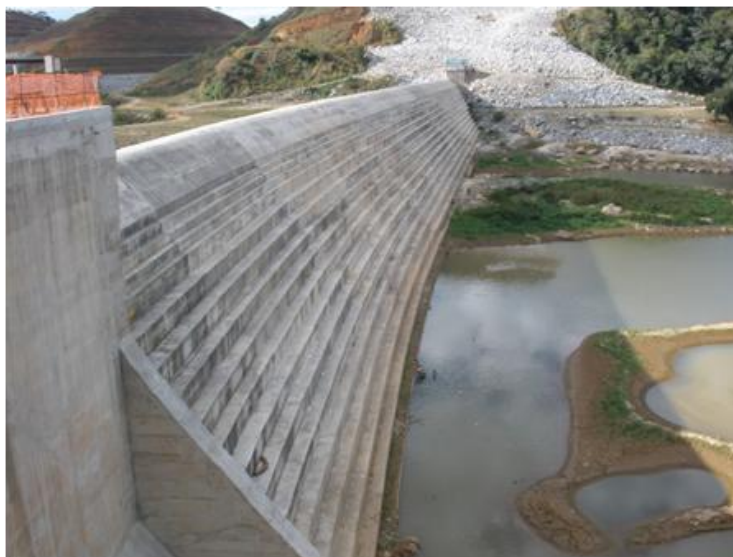
Figura 3: Barragem de CCR, UHE Simplício - Rio de Janeiro (fonte: visita técnica UFRJ, 2012).
