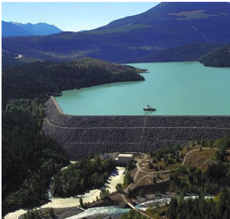
Figura 14: Barragem de terra e enrocamento em Lajoie – Canadá (SAYAO, 2009).
