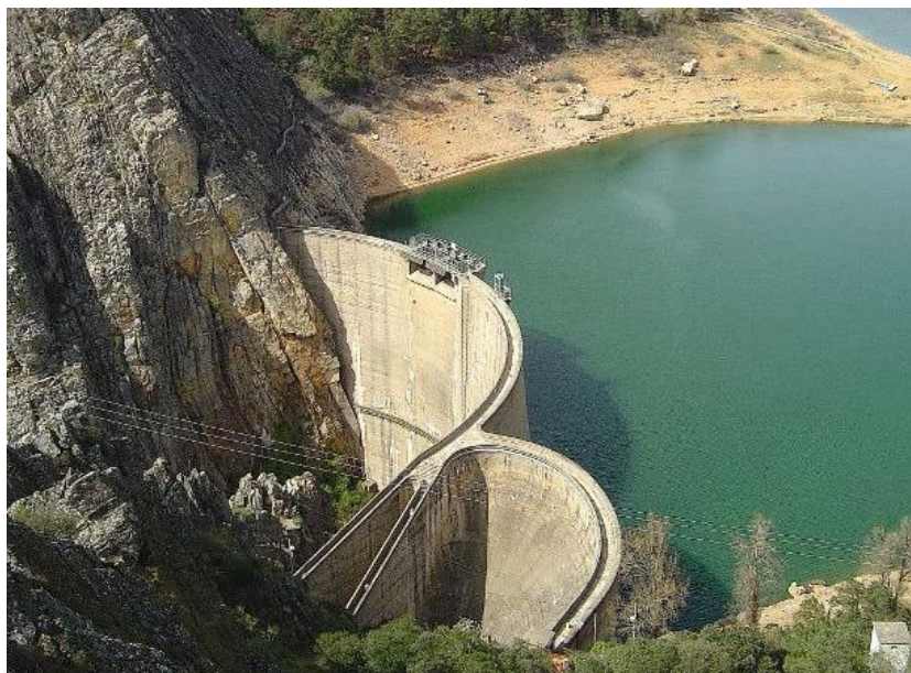
Figura 9: Exemplo de barragem em arcos múltiplos, Santa Luiza – Brasil (SAYÃO, 2009).
