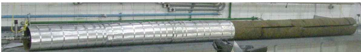
Figura 2.6 - Seção de testes durante a instalação final da cobertura de alumínio corrugado.
