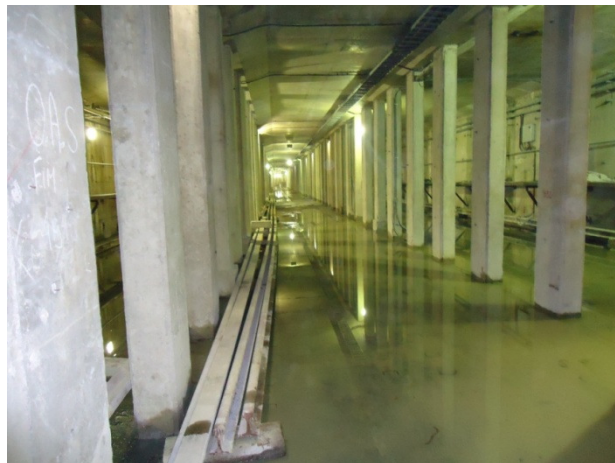
Figura 3.2 - Foto do local onde foi construída a plataforma, em Agosto de 2011.
