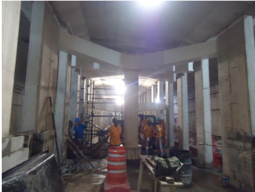
Figura 3.4 - Foto da instalação da árvore e macaqueamento.
