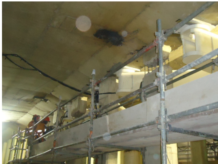
Figura 3.5 - Foto do início do arrasamento de um pilar.
