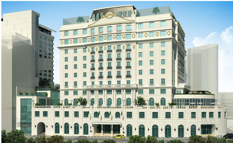
Figura 21 - Hotel Glória - Fachada Restaurada (EBX, 2013)
