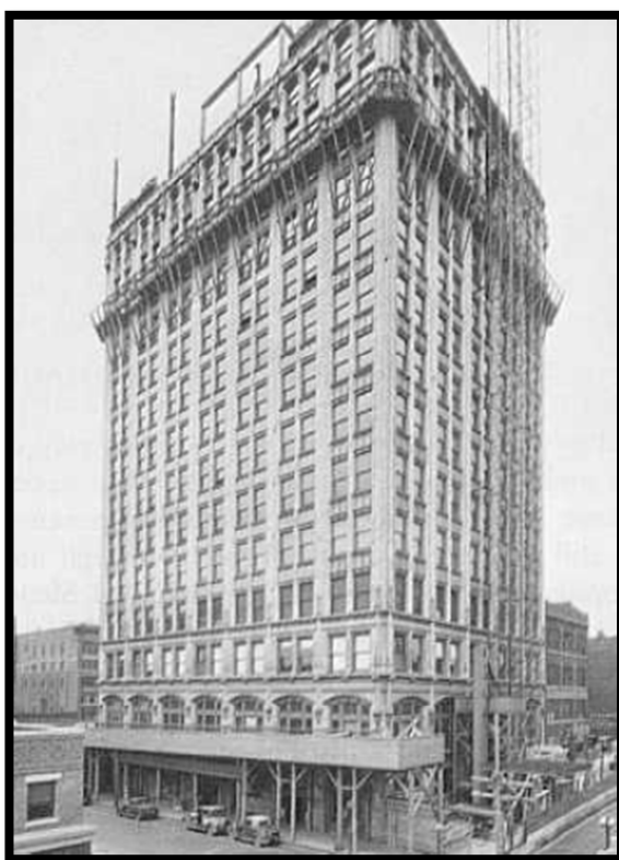
Figura 4 - Edifício da Southwestern Bell Telephone Company, em Kansas, nos Estados Unidos (ESCSI,1971)
