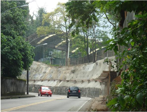
**Figura 43:** Vista geral do talude com o reforço em solo grampeado
