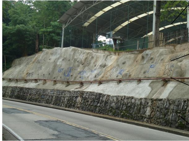
**Figura 44:** Vista geral do talude com o reforço em solo grampeado
