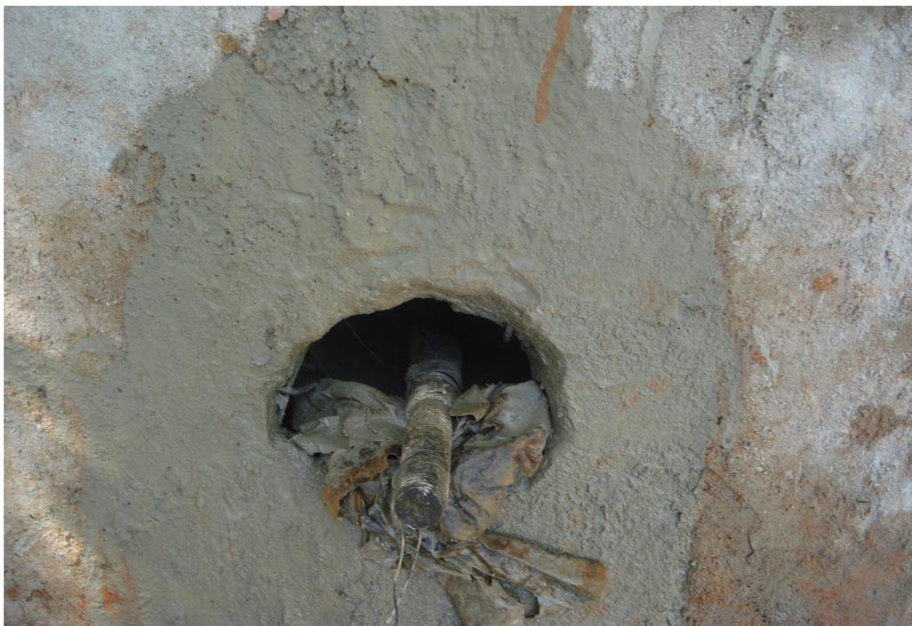
**Figura 56:** Detalhe do grampo executado – barra centralizada com o auxílio de centralizadores
