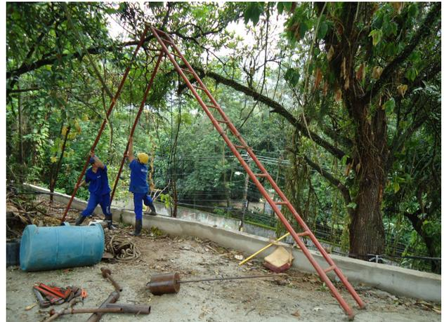
**Figuras 15 e 16:** Montagem do tripé de sondagem no ponto pré-determinado
