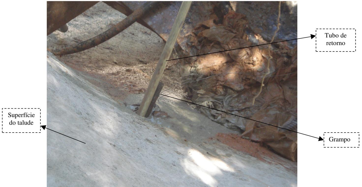
**Figura 55:** Tubo de retorno sendo inserido antes da injeção
