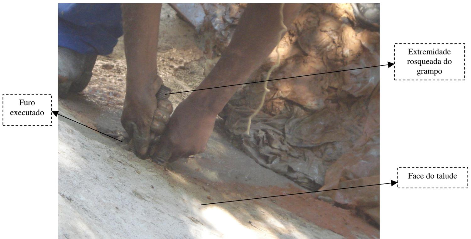
**Figura 53:** Colocação do grampo no interior do furo
