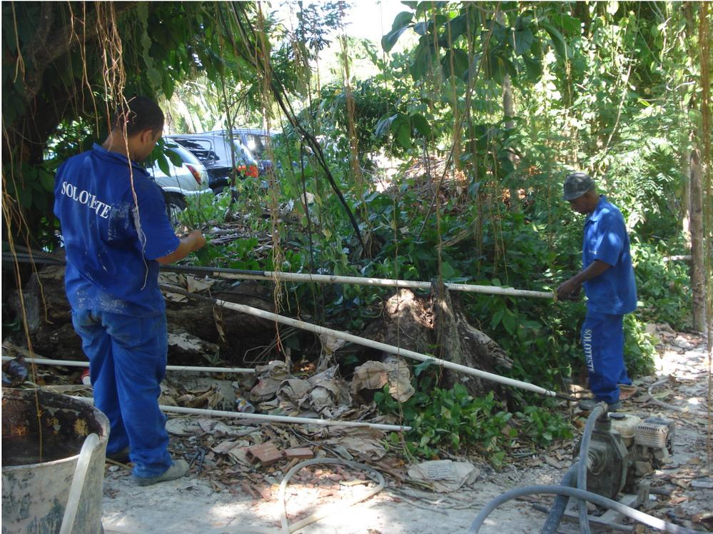
**Figura 52:** Detalhe do grampo sendo preparado: trecho livre de 2,20m revestido com tudo de PVC para evitar a aderência seguido de um trecho de 2,00m a ser ancorado
