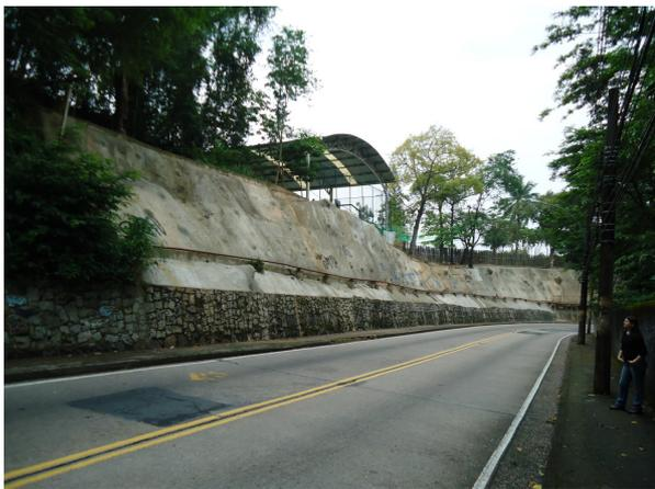
**Figura 45:** Vista geral do talude com o reforço em solo grampeado
