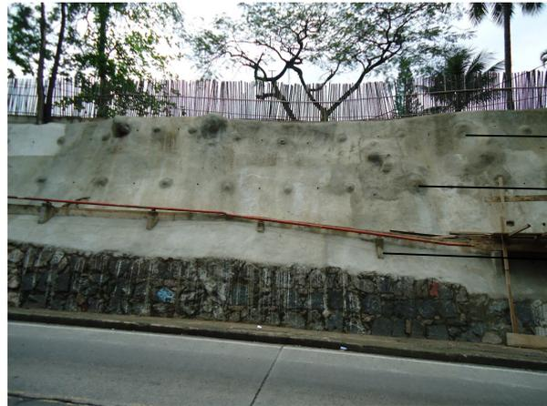
**Figura 46:** Vista frontal do talude com o reforço em solo grampeado
