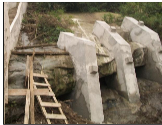
Figura 3.24 - Contrafortes para a contenção dos blocos e lascas maiores.
