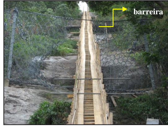
Figura 3.23 - Plano inclinado para acesso a parte superior da encosta.
