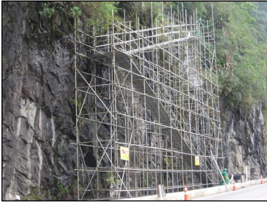
Figura 3.20 - Andaimes para vencer desnível junto à rodovia.
