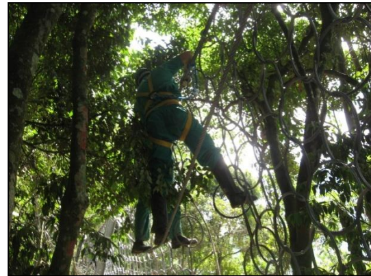
Figura 3.25 - Montagem das Barreiras
