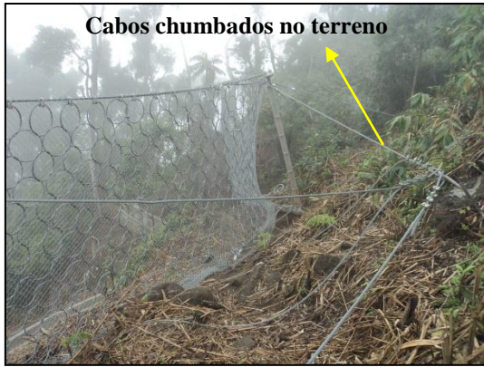
Figura 3.26 - Vista da fixação da barreira a montante
