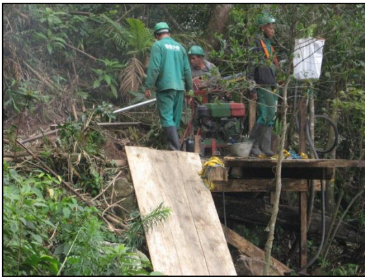
Figura 3.21 - Perfuração dos Chumbadores.
