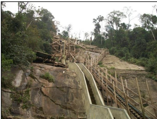
Figura 3.22 - Descida d'água em degraus.
