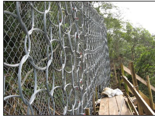
Figura 3.27 - Vista lateral da barreira.
