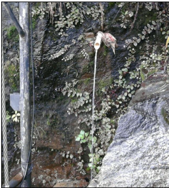
Figura 3.15 - Detalhe de um dos drenos instalados
