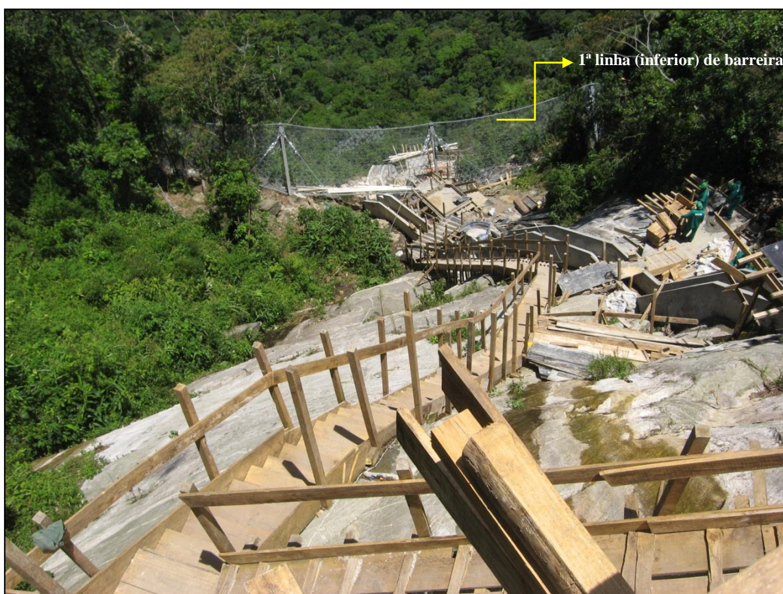
Figura 3.19 – Vista (de cima para baixo) da cicatriz do deslizamento durante execução da obra de estabilização.
