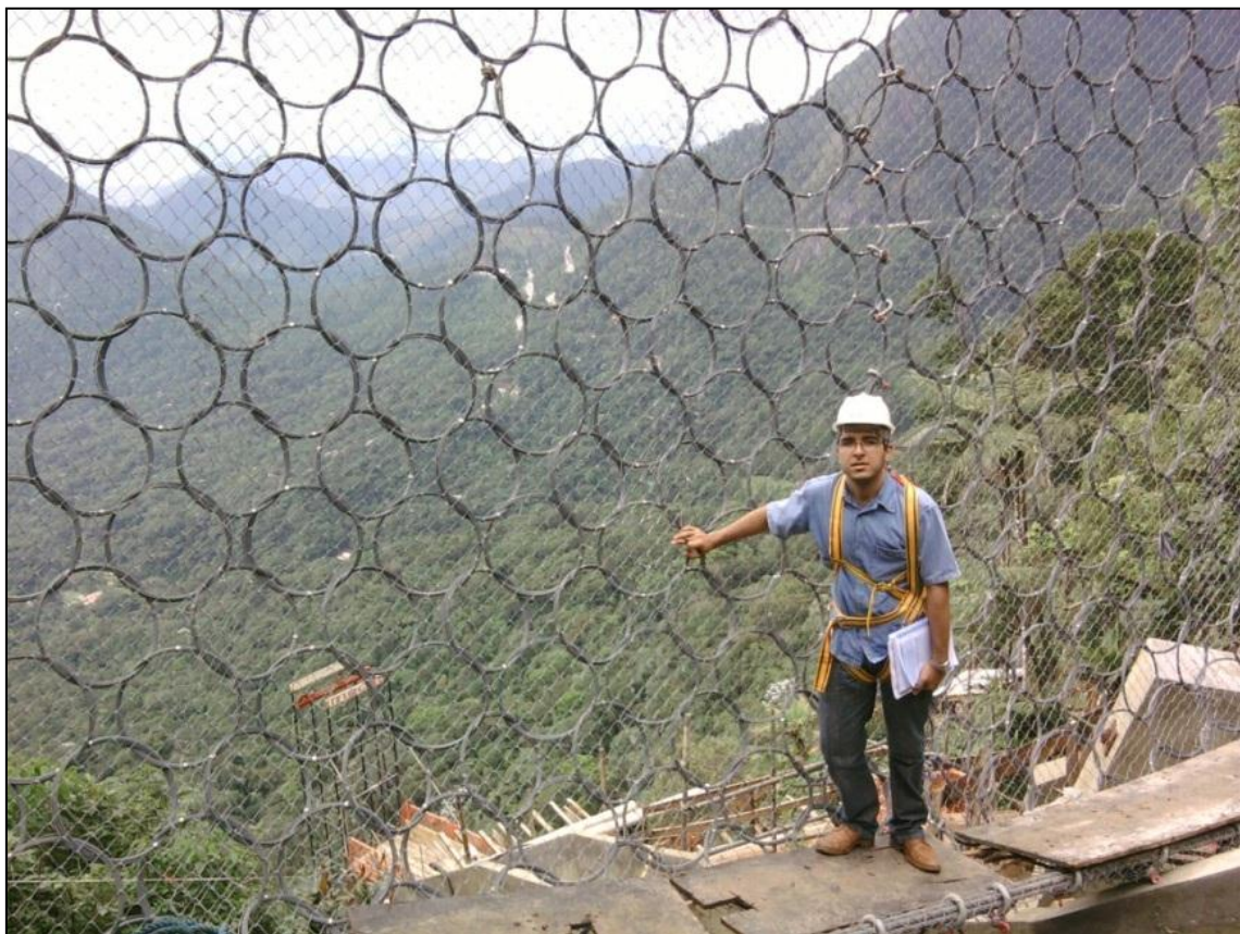
Figura 3.28 – Vista da Barreira da Linha Superior.
