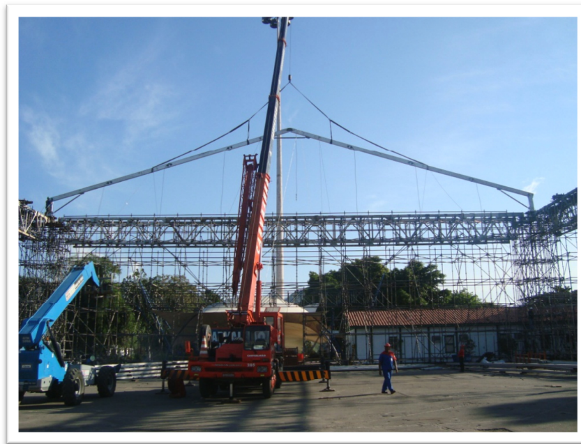
Figura 10.1: Içamento do conjunto de vigas (MVD Eventos, 2011)
