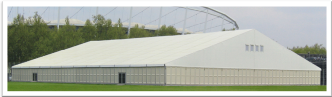
Figura 1.4: Galpão com 50 metros de vão livre (Losberger, 2011)
