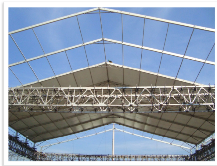
Figura 10.3: Galpão com as lonas de cobertura parcialmente colocadas (MVD Eventos, 2011)
