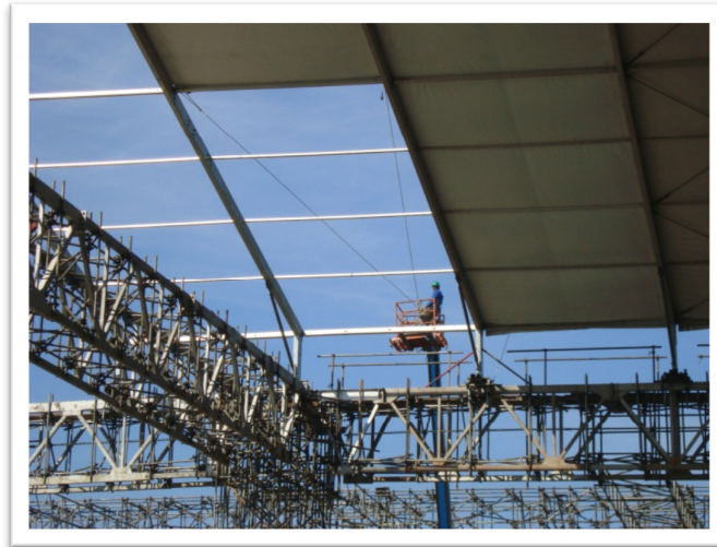
Figura 10.2: Colocação da lona de cobertura (MVD Eventos, 2011)
