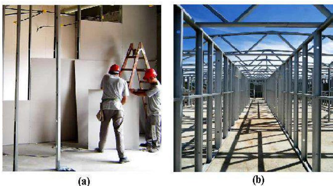
Figura 1.5 – Sistemas estruturais constituídos de PFF: (a) *Drywall* (b) *Steelframe* (GYPSTEEL)
