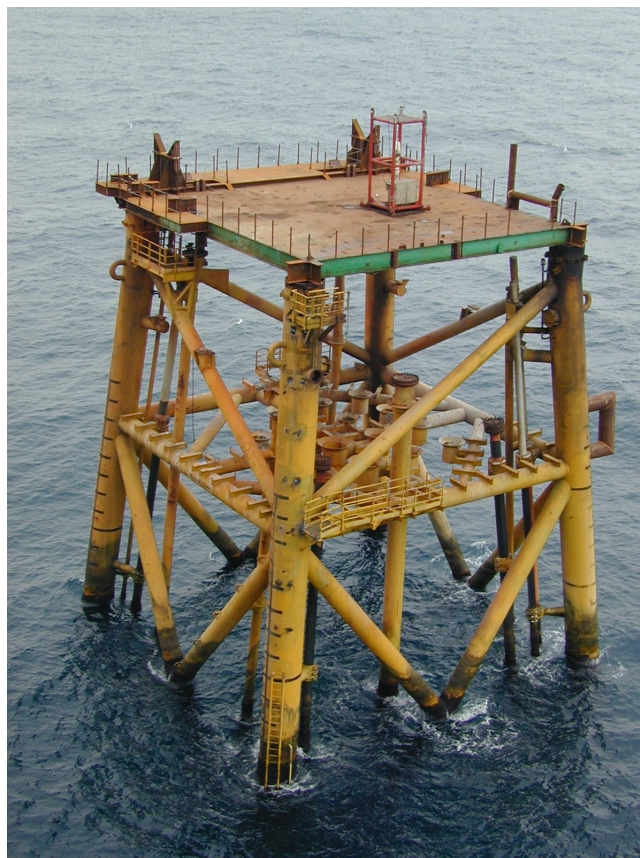
Figura 2.1 – Plataforma Frøi localizada no Mar do Norte.
