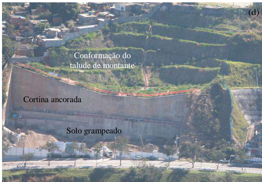
Figura VI.8 – Registro fotográfico da sistema de contenção composto por cortina ancorada (superior) e solo grampeado (inferior): (a) visão aérea; (b) lateral esquerda; (c) lateral direita e (d) vista frontal da obra em execução.
