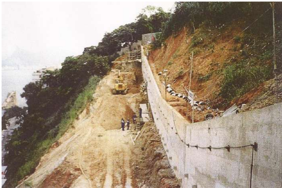
Figura VI.2 – Execução da cortina através de escavação descendente em nichos.
