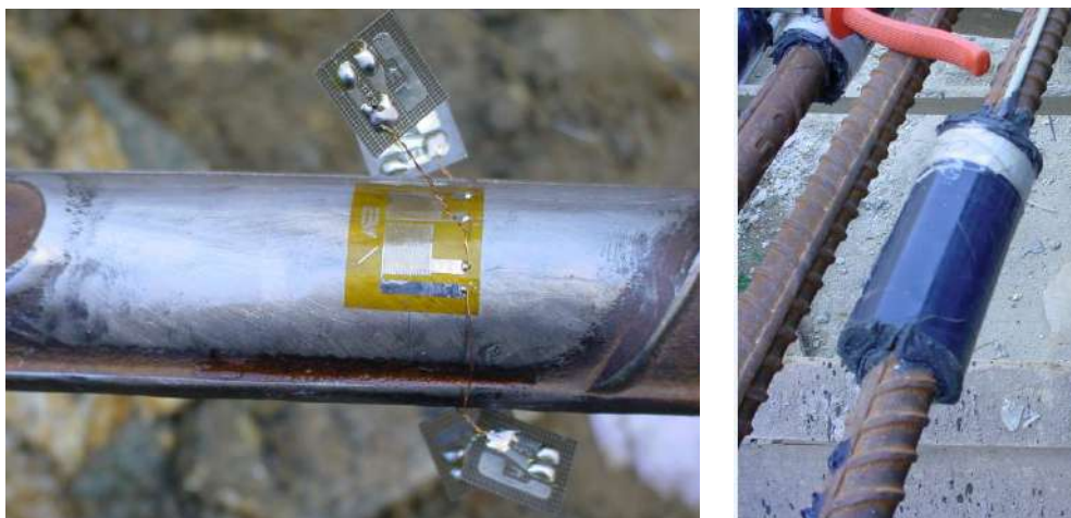
Figura VI.15 – Instalação e proteção dos pontos instrumentados.
