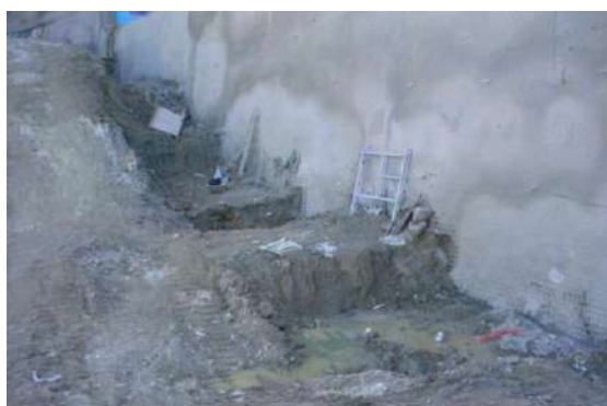
Figura VIII.12 – Processo executivo da escavação em solo grampeado.
