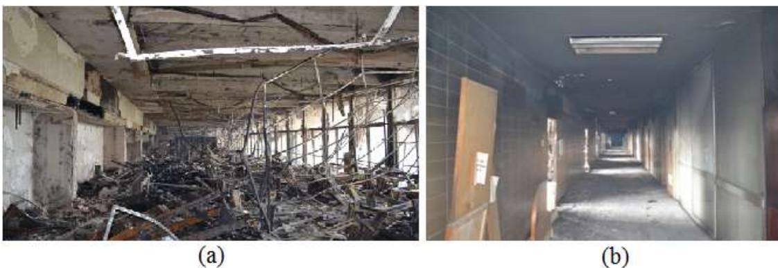
Figura 1.3: Danos causados pelo acidente nas instalações do Ed. JMM: (a) sala de início do incêndio; (b) corredor do oitavo andar [1].
