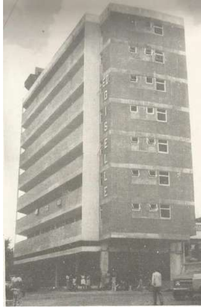
Figura 5.21 – Edifício Giselle ainda em construção (JABOATÃO ANTIGO, 2014)
