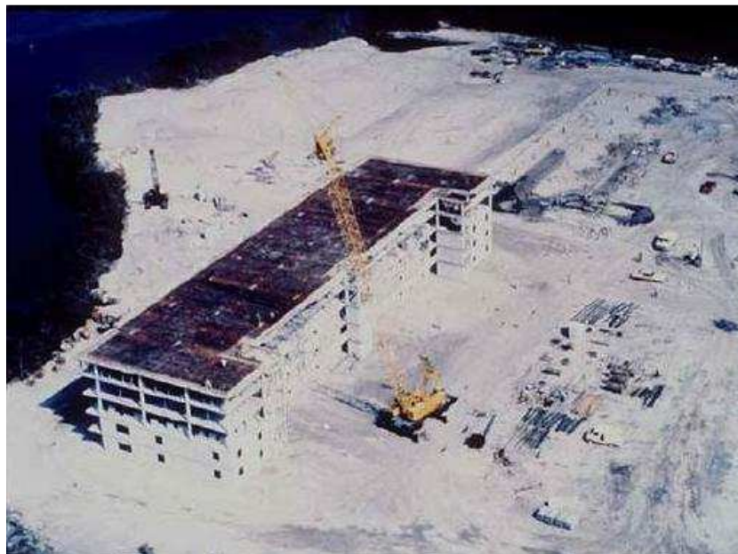
Figura 5.32 – Vista aérea do Harbour Cay Condominium antes do colapso (KUKORLO, 2009)
