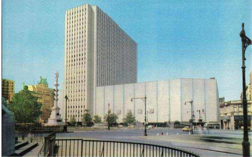
Figura 5.25 – Vista do New York Coliseum após construído em 1956 (SCHWAB, PINKETT, et al. , 2010)
