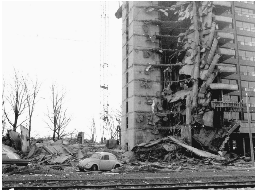
Figura 5.27 – Colapso do prédio em Boston (KING e DELATTE, 2004)
