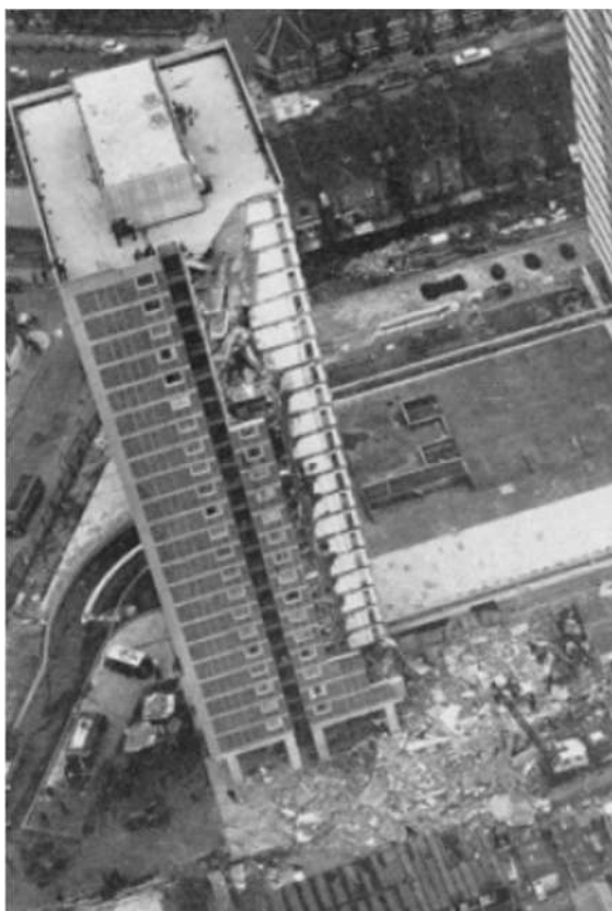
Figura 1.1 – Edifício Ronan Point após colapso parcial (CANISIUS, 2011)
