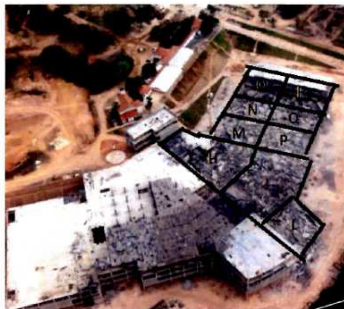
Figura 5.14 – Setores do Shopping Rio Poty que desabaram (CREA-PI, 2013)
