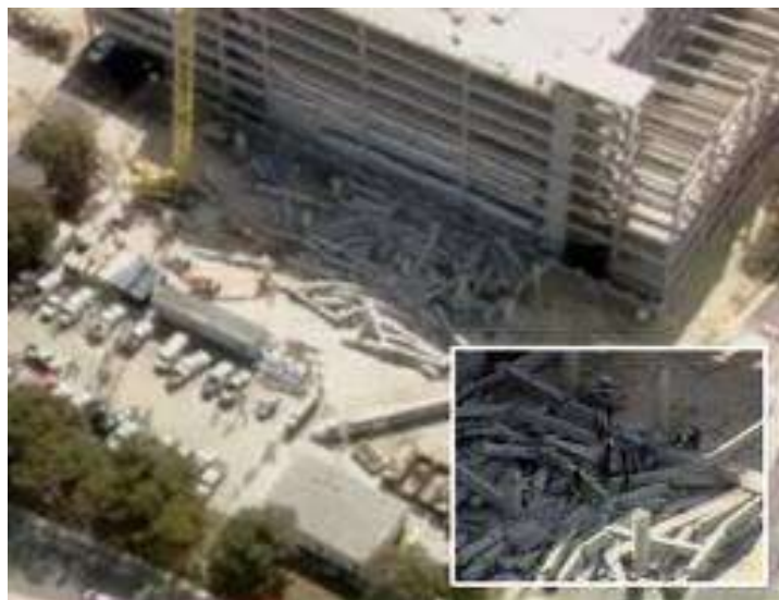
Figura 5.43 – Vista aérea do colapso da parte norte do UHS West Parking Garage (JIANG, 2012)
