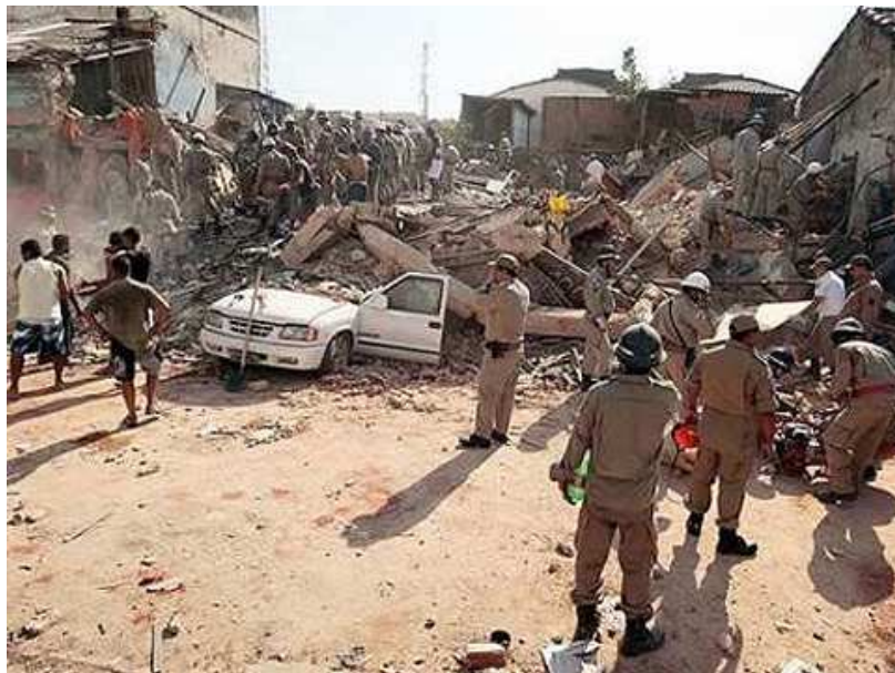
Figura 5.9 – Escombros do edifício Raimundo Farias (PORTAL ORM, 2011)
