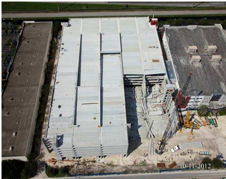
Figura 5.46 – Vista área de parte do edifício-garagem colapsado na Florida (OSHA, 2013)
