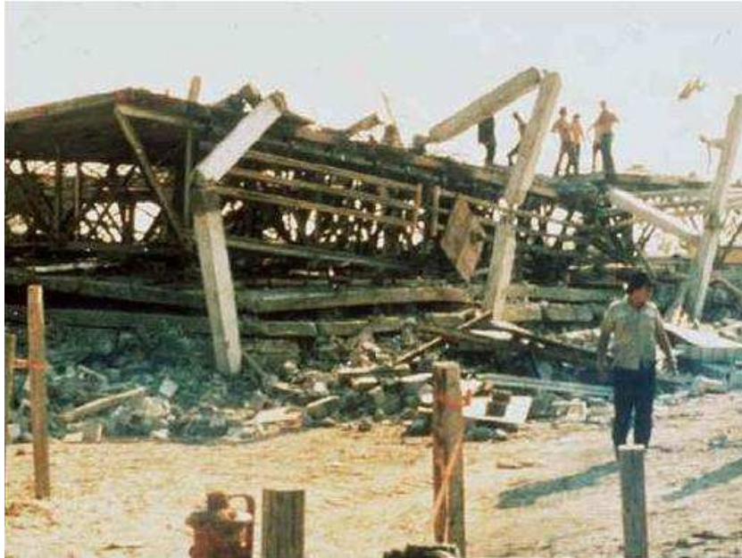
Figura 5.33 – Harbour Cay Condominium após o colapso progressivo (KUKORLO, 2009)
