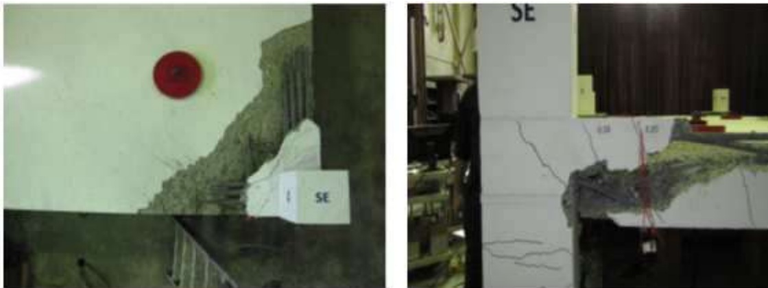
Figura 6.7 – Aspecto pós-ruptura por punção de região de pilar de canto (ZHANG, 2014)
