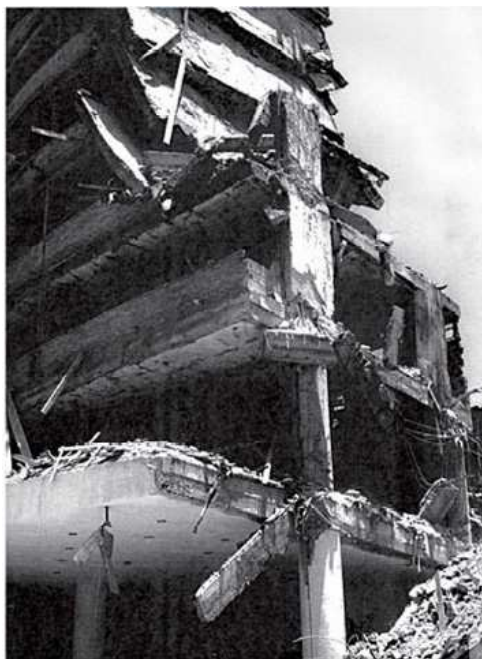
Figura 5.5 – Vista parcial do Edifício Comurba após o colapso (VASCONCELOS, 1998)
