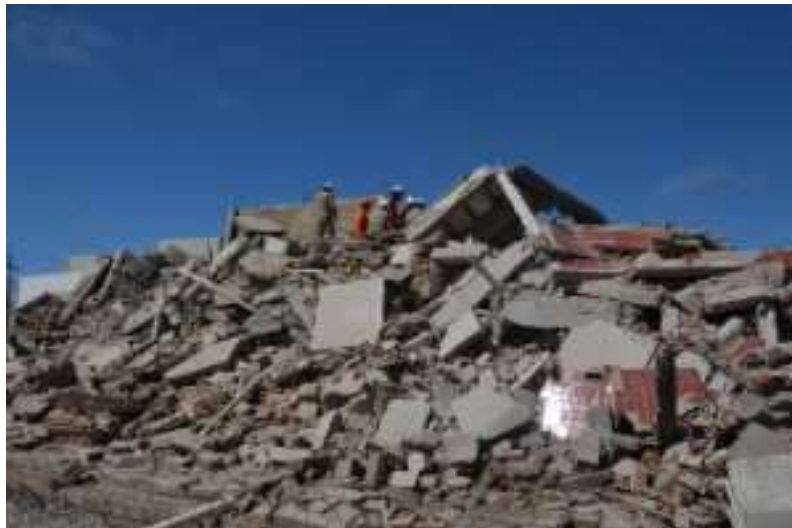
Figura 5.19 – Escombros resultantes do desabamento do prédio em Aracaju (CREA-SE, 2015)
