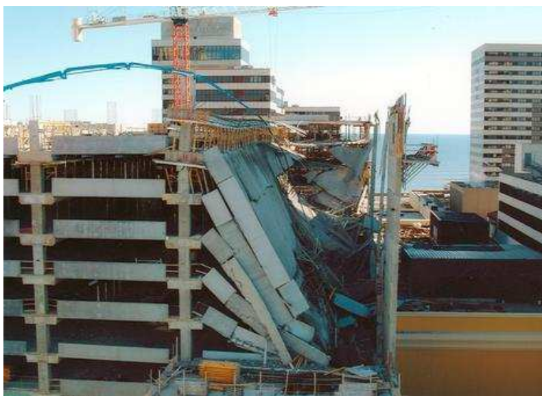
Figura 5.39 – Vista geral do colapso da parte oeste do estacionamento do Tropicana Casino Resort (ENGEL, JULIUS, et al. , 2010)
