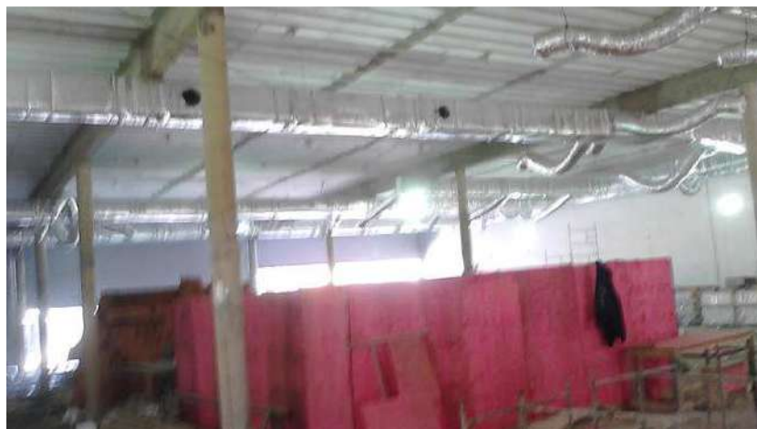
Figura 5.18 – Pilares esbeltos na obra do prédio em São Mateus (FRAZÃO e YARAK, 2013)
