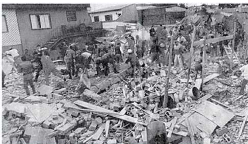
Figura 5.12 – Colapso total do edifício residencial em São Paulo no ano de 1994 (VELLOSO, NAEGELI e VIDEIRA, 1998)
