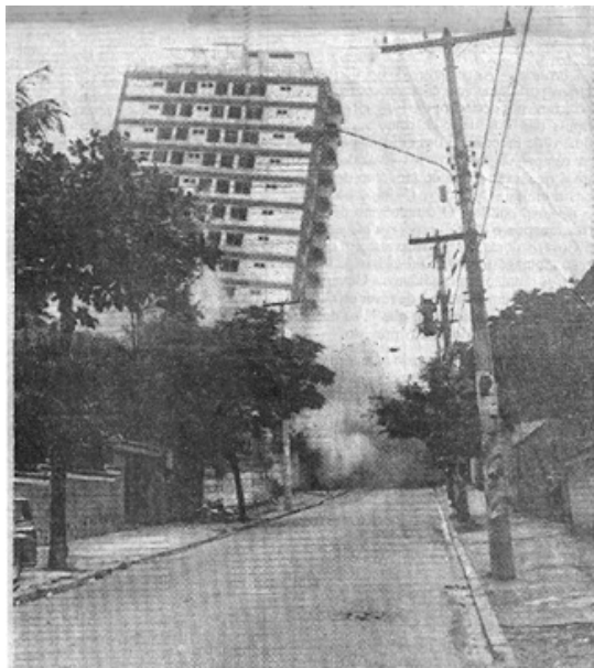
Figura 5.22 – Inclinação do edifício em Icaraí momentos antes do colapso (RAMOS, 2001)
