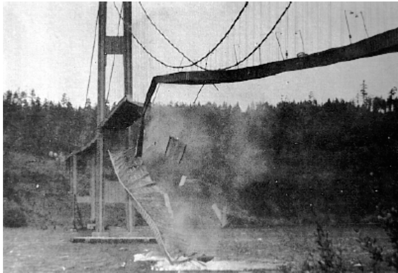
Figura 2.6 – Exemplo de colapso do tipo zíper (STAROSSEK, 2009)
