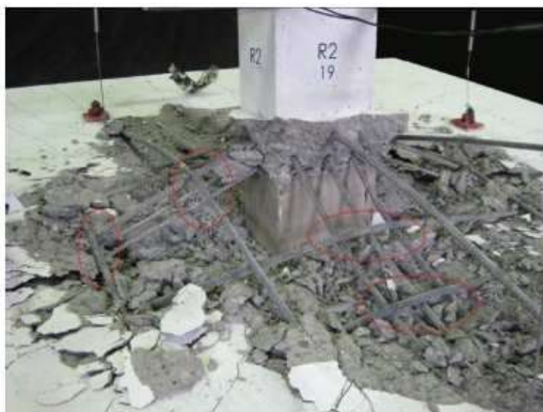
Figura 6.5 – Aspecto pós-ruptura por punção de região com pilar interno (EGBERTS, 2009)
