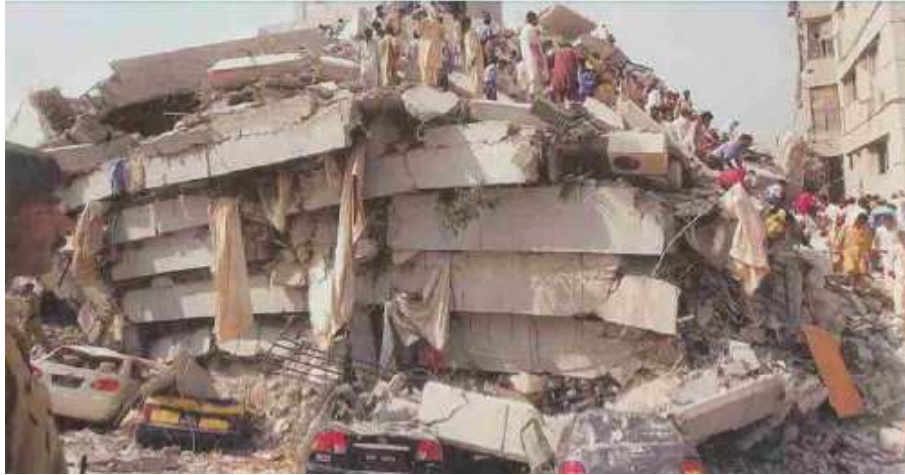
Figura 2.2 – Exemplo de colapso do tipo panqueca (STAROSSEK, 2009)
