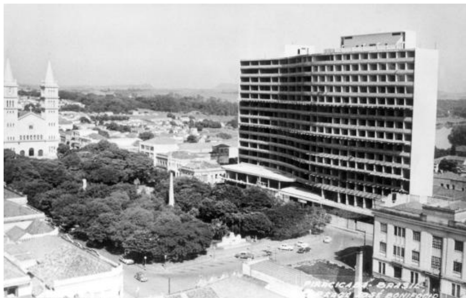
Figura 5.4 – Edifício Comurba antes do colapso (TOMAZELA, 2014)
