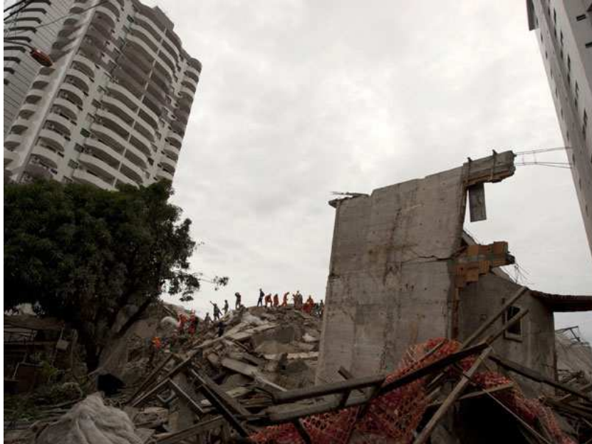
Figura 5.13 – Escombros do edifício Real Class (JORNAL O PROGRESSO, 2011)
