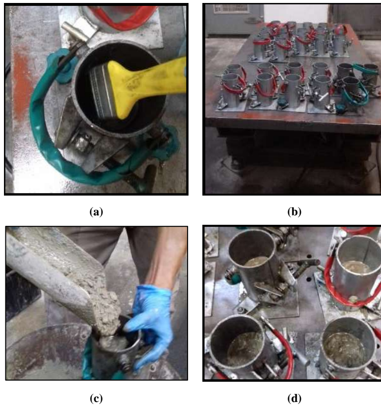
Figura 4.3 - Moldagem dos concretos: (a) pintura com óleo; (b) moldes; (c) lançamento do concreto no molde; (d) primeira camada após adensamento.
