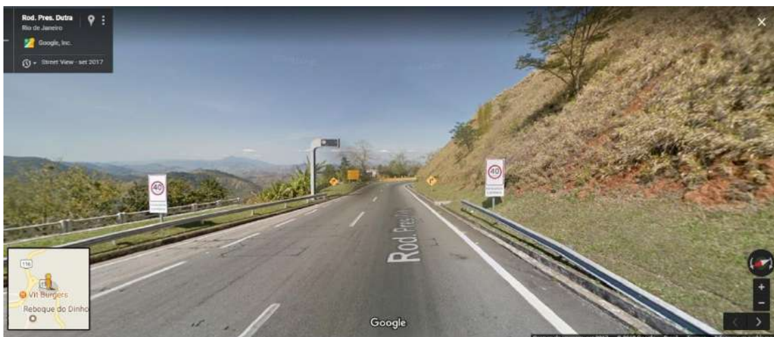
Figura 115 - Sinalização de controle de velocidade da Serra das Araras Fonte: Google Maps
