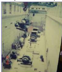
Elevatória da Zona Rural (NEZR) – 1994
