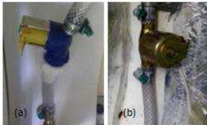
Figura 3.8 –Válvula solenoide: (a) plástica; (b) metálica
