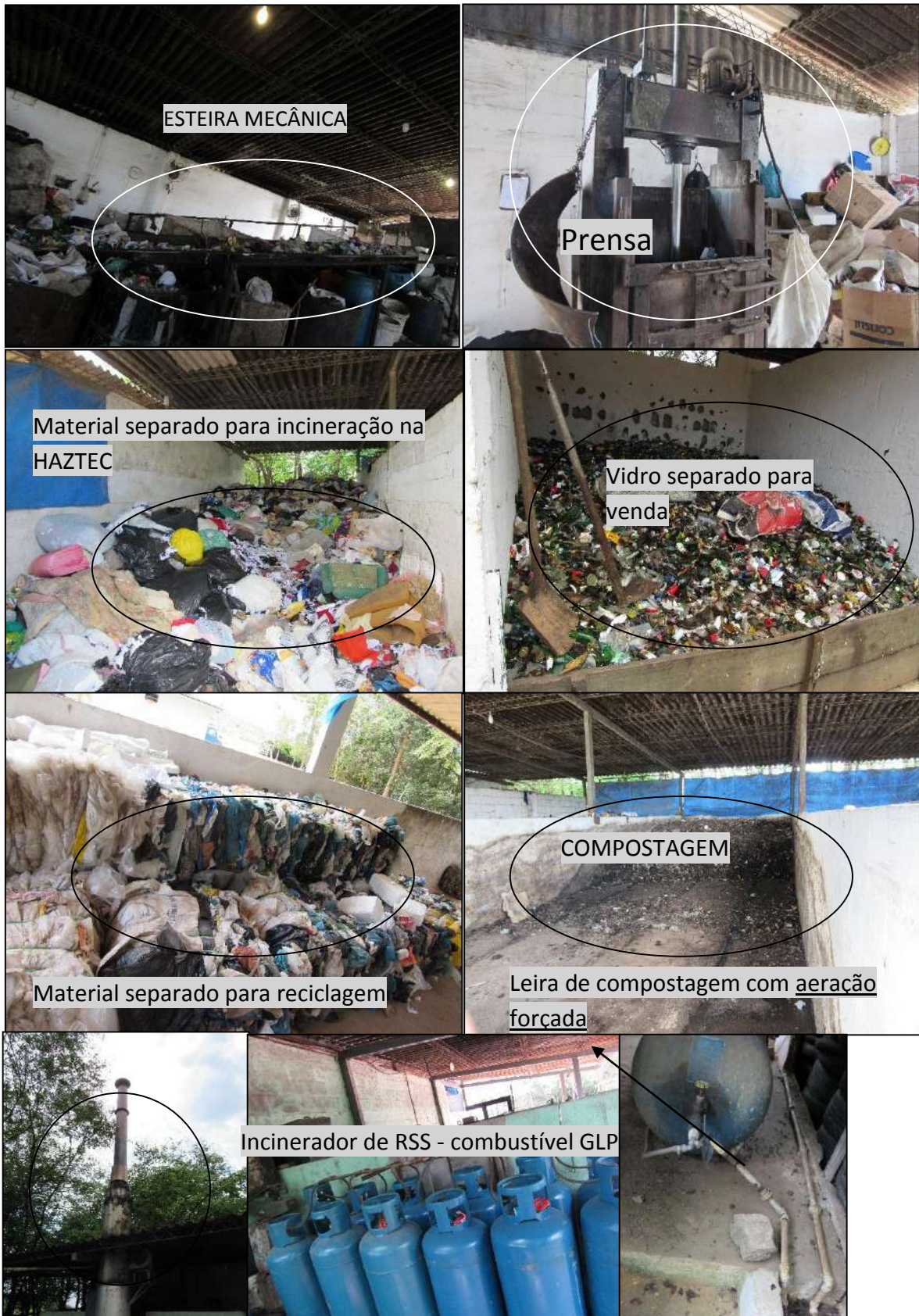
Figura 37: Usina de Triagem e Tratamento de Resíduos de Cantagalo-RJ. Mosaico com os diversos tipos de produtos e instalações
