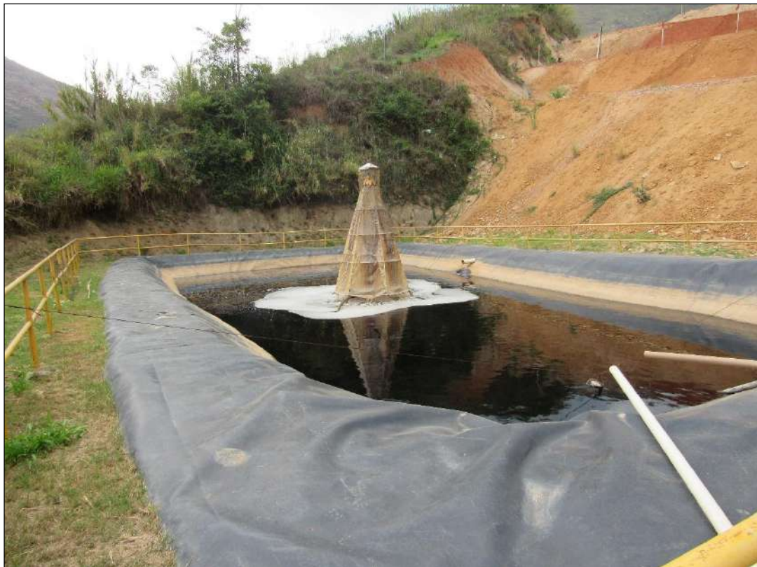
Figura 46: Aterro Sanitário de Pedro do Rio – lagoa de acumulação e pré-tratamento de chorume Fonte: pesquisa de campo – 03/11/2016
