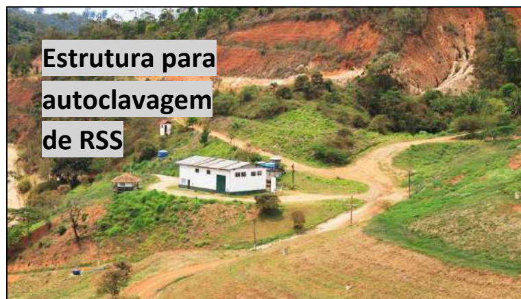
Figura 68: Estrutura de Tratamento de RSS - autoclavagem Fonte: http://www.ebma.com.br/servicos/ -acessado em 20/11/2016
