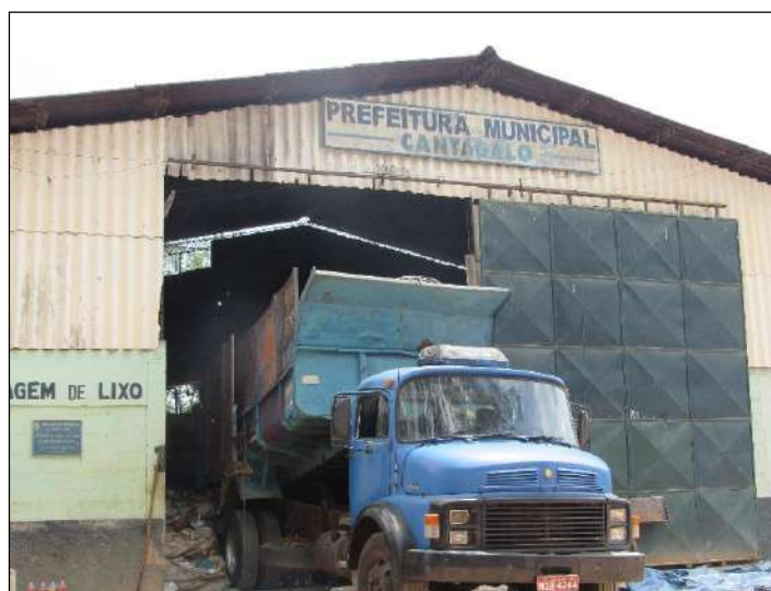
Figura 36: Entrada da Usina de Triagem e Tratamento de Resíduos de Cantagalo-RJ Fonte: pesquisa de campo - 27/10/2016
