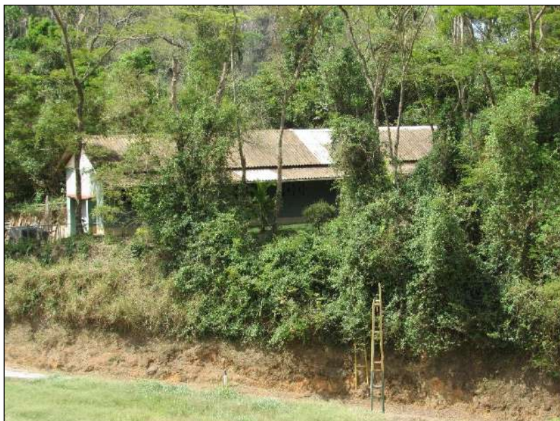
Figura 44: Aterro Sanitário de Pedro do Rio – vista do incinerador de Resíduos do Serviço de Saúde (fora de operação) Fonte: pesquisa de campo – 03/11/2016
