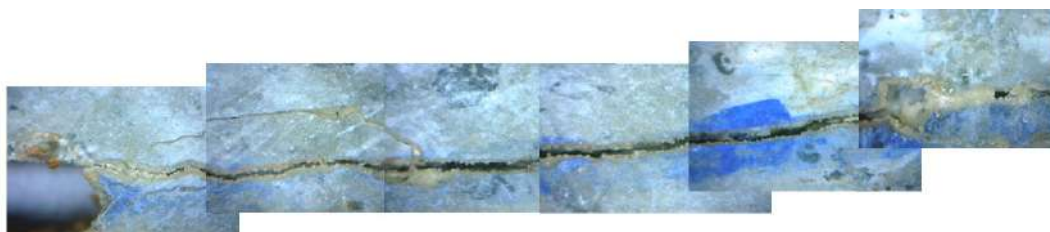
Figura 4.77: Fissura de A16 após tratamento
