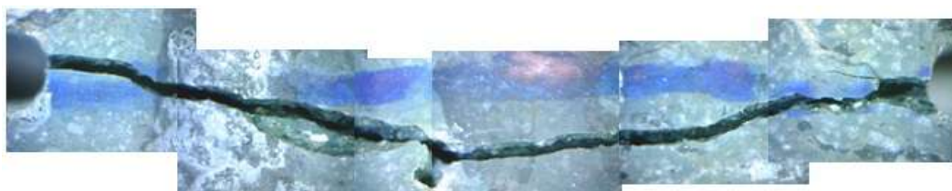
Figura 4.40: Formação da fissura da amostra A24
