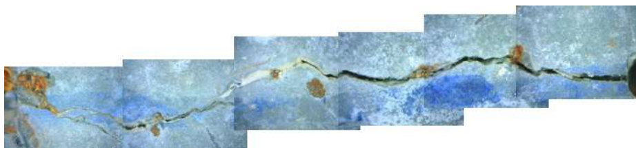
Figura 4.106: Incompleto selamento da fissura do C37
