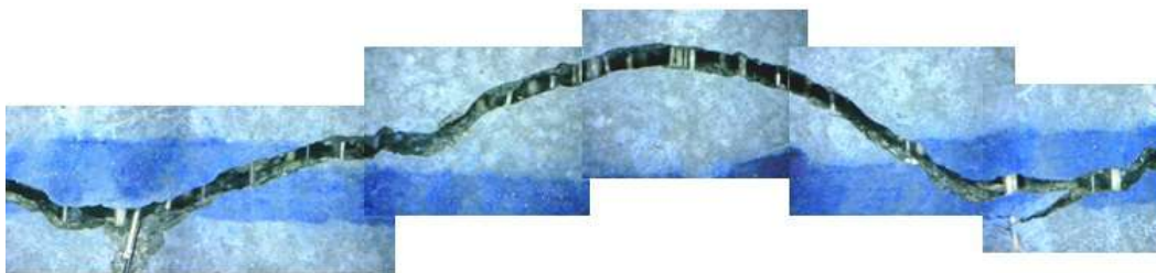
Figura 4.53: Formação da fissura da amostra C34
