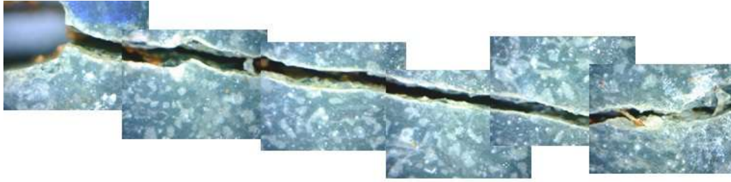
Figura 4.87: Incompleto selamento da fissura do A23
