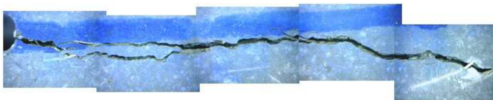
Figura 4.54: Formação da fissura da amostra B34
