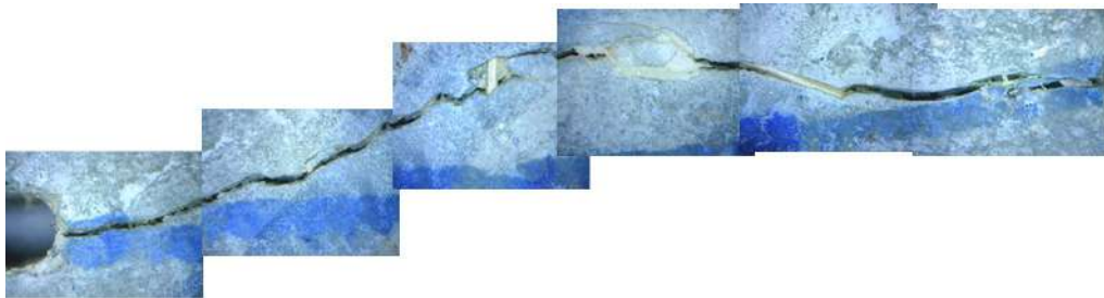
Figura 4.100: Incompleto selamento da fissura do C36
