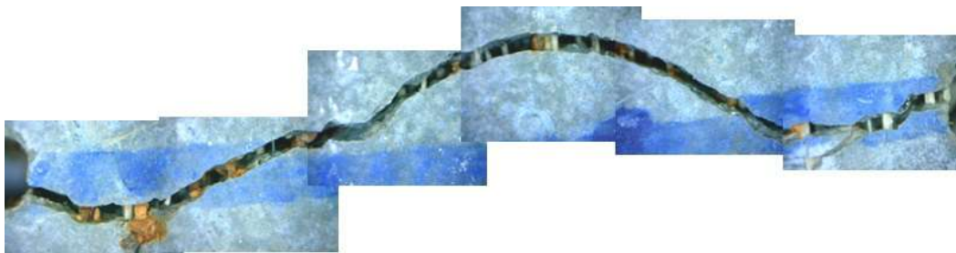
Figura 4.116: Incompleto selamento da fissura do C34
