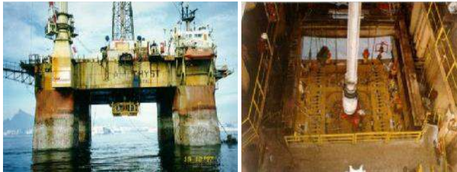
Figura 4.7 Manifold conectado ao riser de perfuração de uma plataforma semissubmersível (RIBEIRO, 2008)
