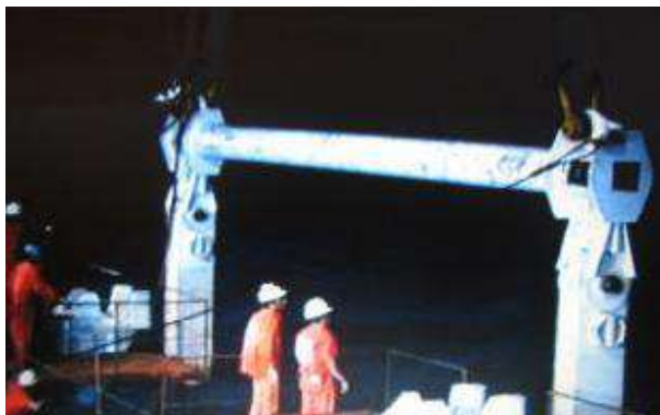
Figura 4.5 Instalação de manifold com eslinga em Albacora (RIBEIRO, 2008)
