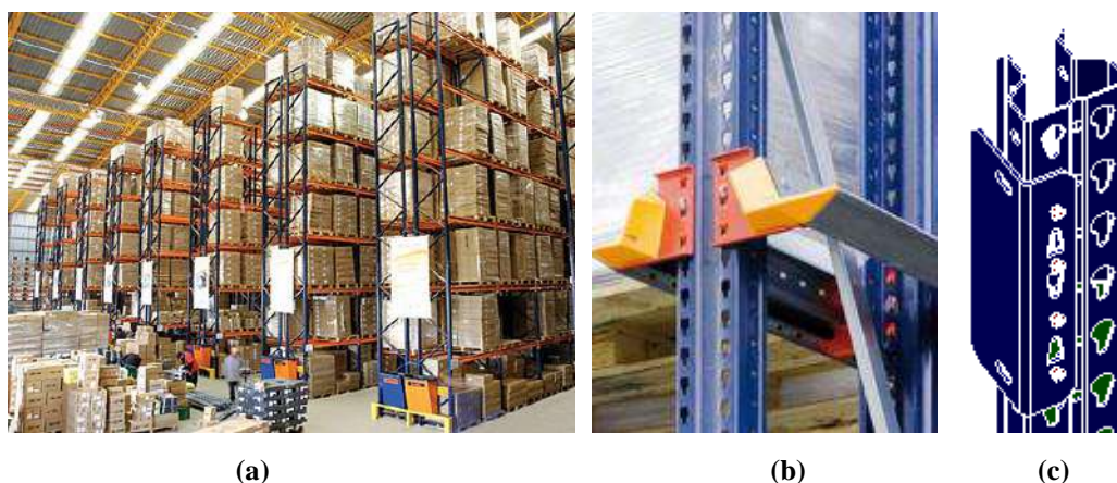
Figura 1.6. (a) Estrutura de armazenagem industrial – porta- pallets – (b) e (c) chapas da conexão viga-coluna (METALSHOP, 2016) 5 .
