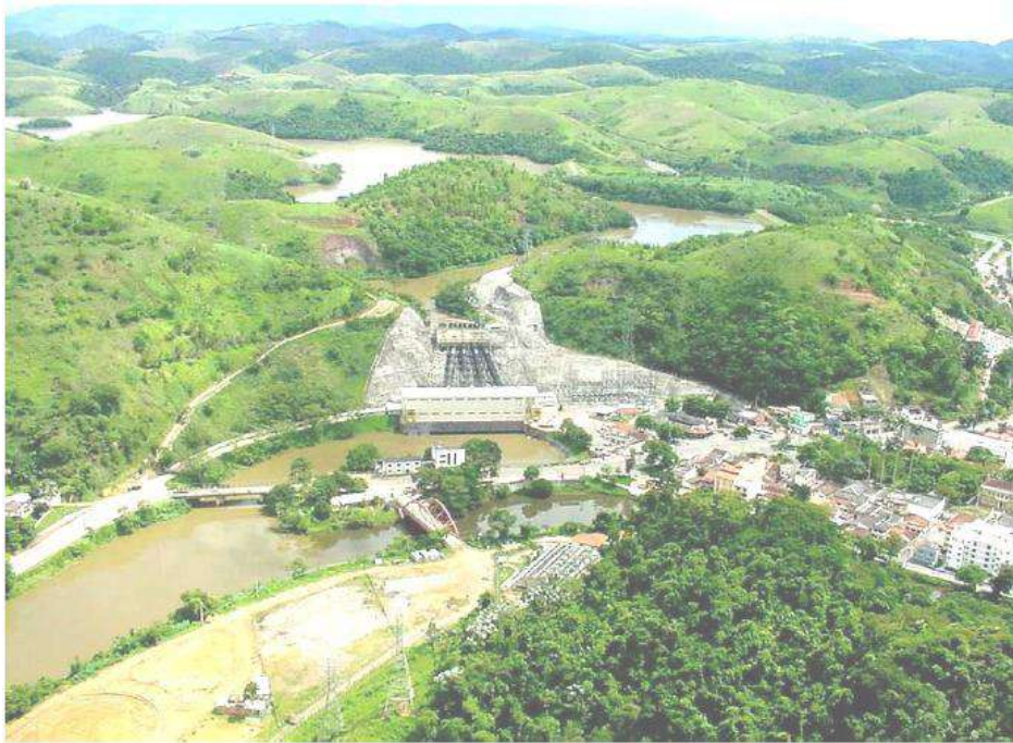
Figura 3.4 – Usina elevatória de Vigário, município de Pirai. Fonte: Light (2016a).
