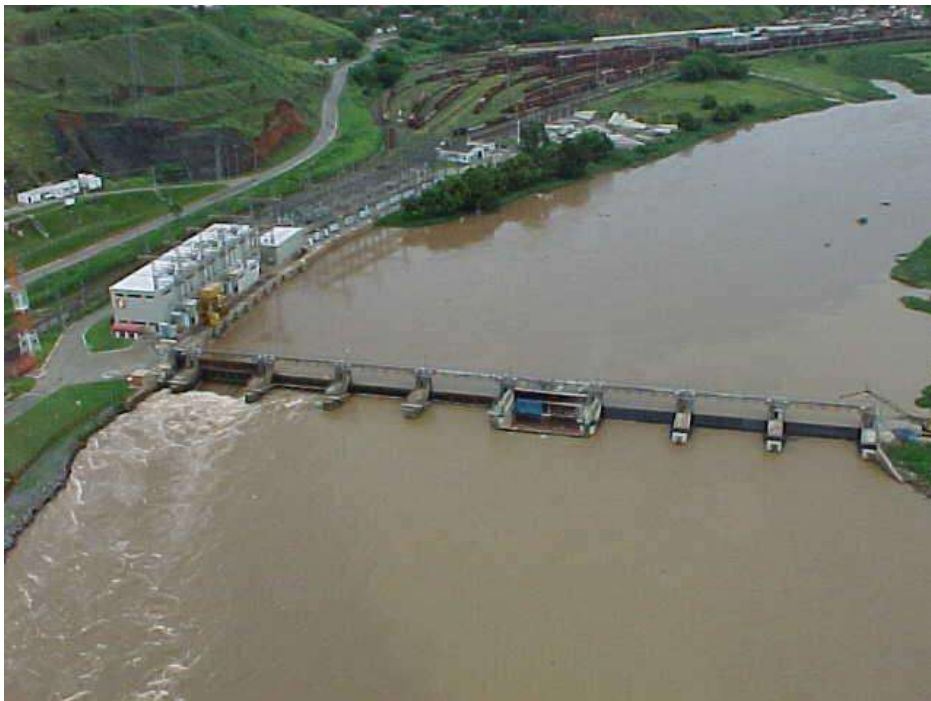
Figura 3.5 – Usina elevatória de Santa Cecilia, município de Barra do Pirai. Fonte: Light (2016a).
