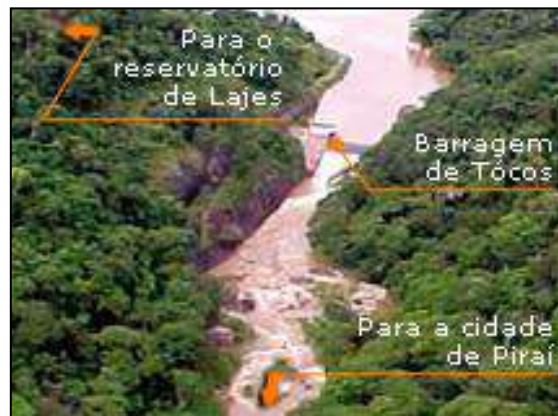
Figura 3.2 – Túnel de Tocos, desvio do Rio Piraí para o reservatório de Ribeirão das Lajes Fonte: Light (2016a).
