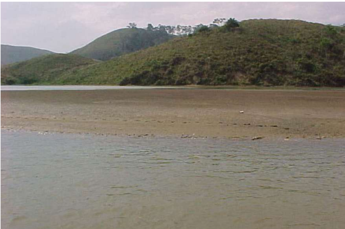
Figura 3.19 – Assoreamento do reservatório de Santana. Fonte: LIGHT (2016a).
