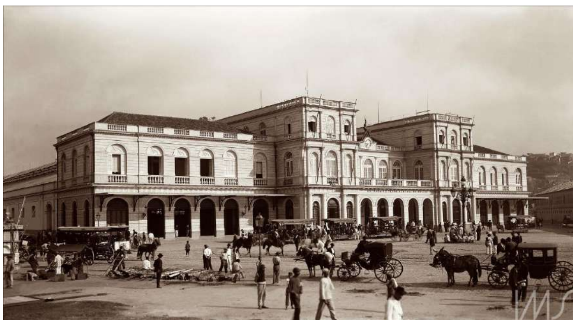
Figura 3.1 – Estação da estrada de ferro Central do Brasil.
