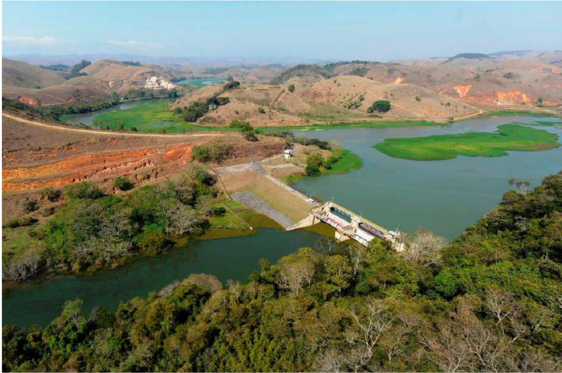
Figura 3.16 – Reservatório de Santana atualmente. Fonte: LIGHT (2016a).
