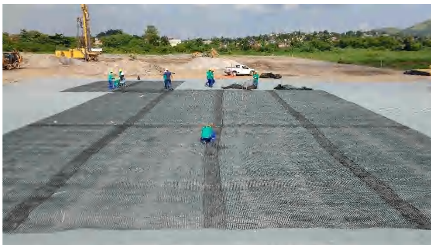
Figura 3.7 – Instalação geotêxtil e geogrelha
