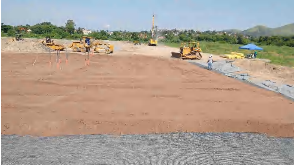
Figura 3.9 – Execução da camada drenante de 0,40 m
