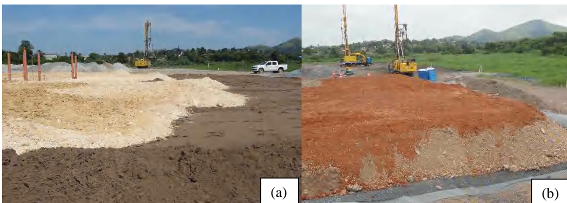
Figura 3.10 – (a) Lançamento da primeira camada e (b) lançamento da quinta camada
