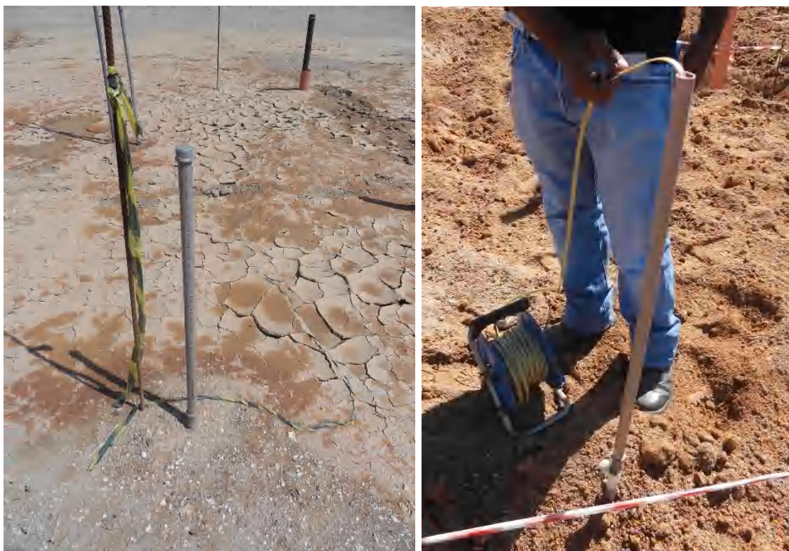
Figura 3.22 – Acompanhamento da leitura dos piezômetros
