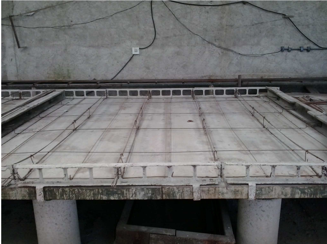
Figura 3-16 Montagem da armação (Autor 2013)
