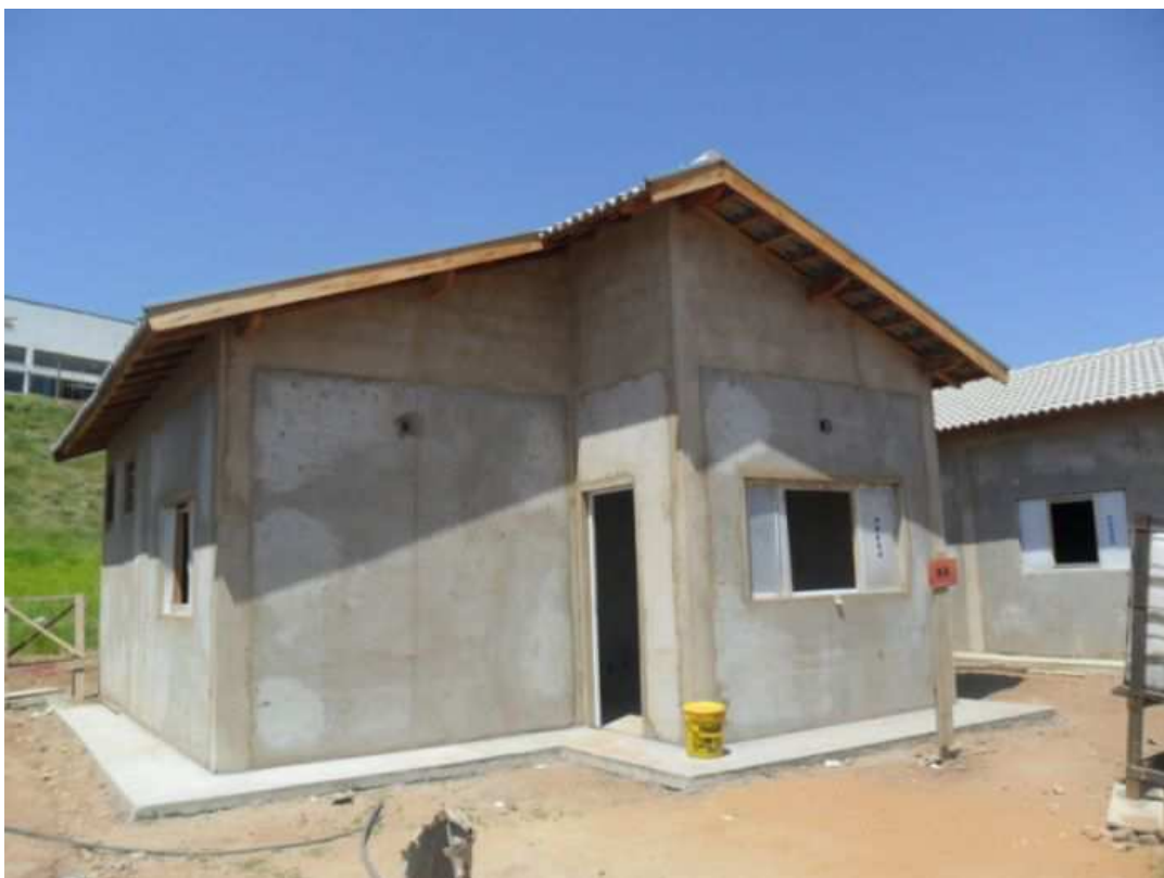
Figura 3-12 Habitação com estrutura concluída (Concrecasa 2012)
