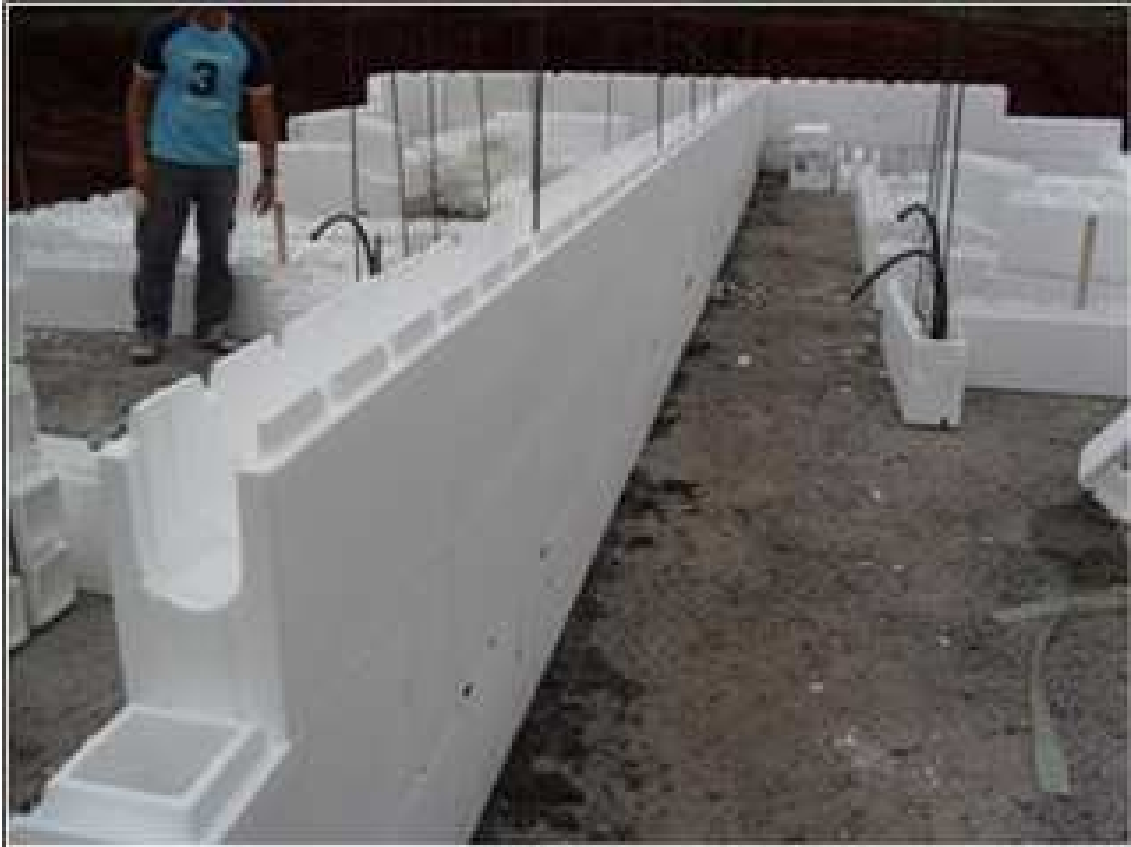
Figura 2-5 blocos de EPS de alta densidade (JJ Design Arquitetura, 2008)
