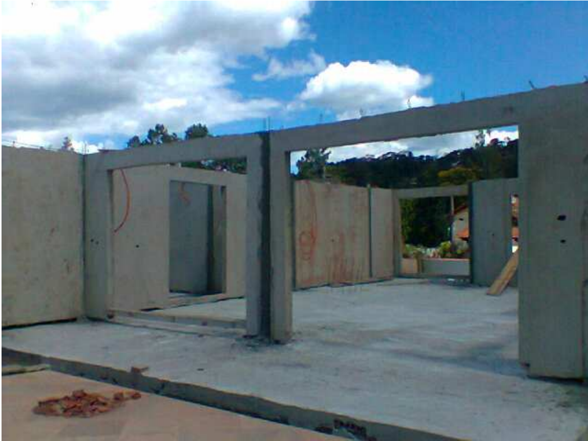
Figura 3-10 Detalhes da solda entre as armações dos painéis (Autor 2012)
