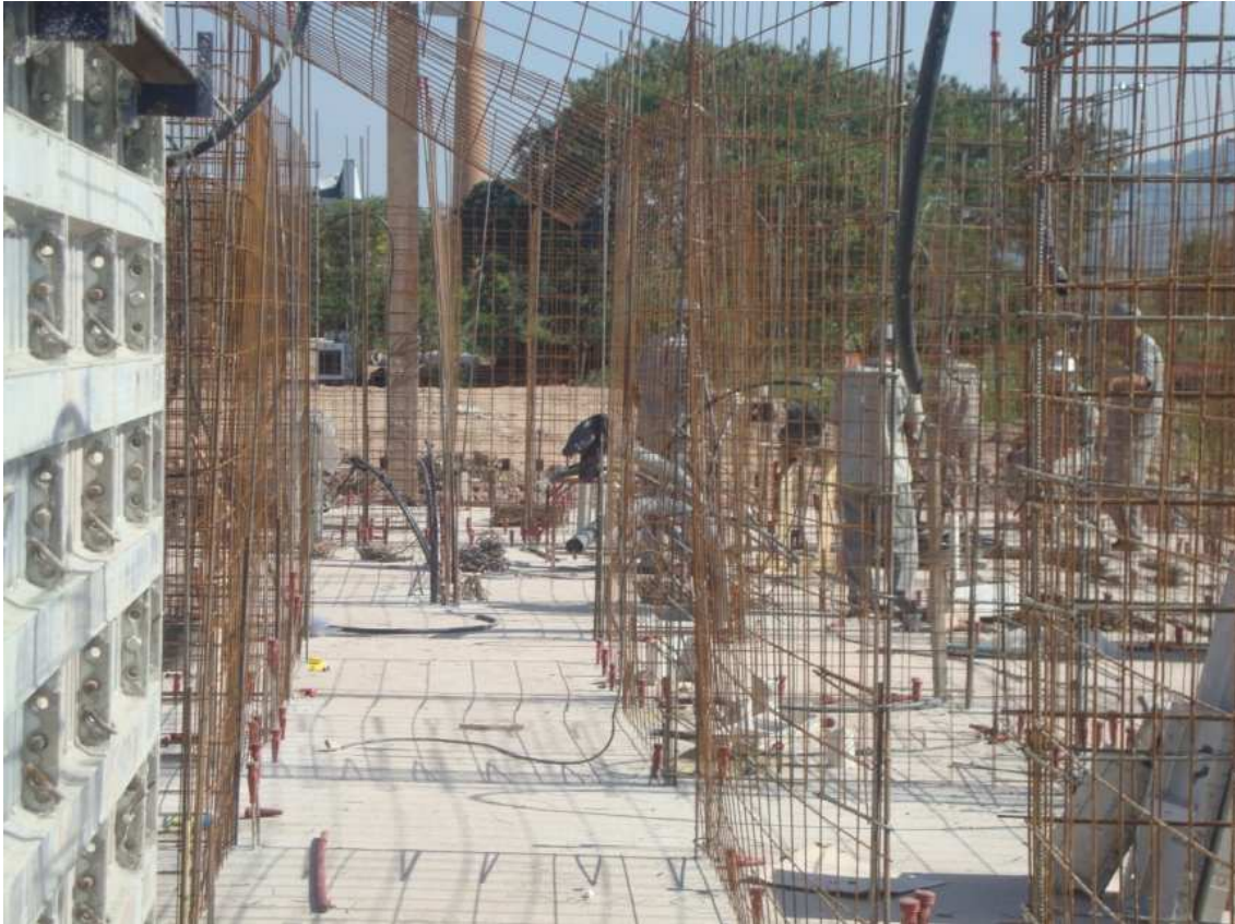
Figura 2-15: Armação de uma etapa de concretagem. (Arêas, 2013)
