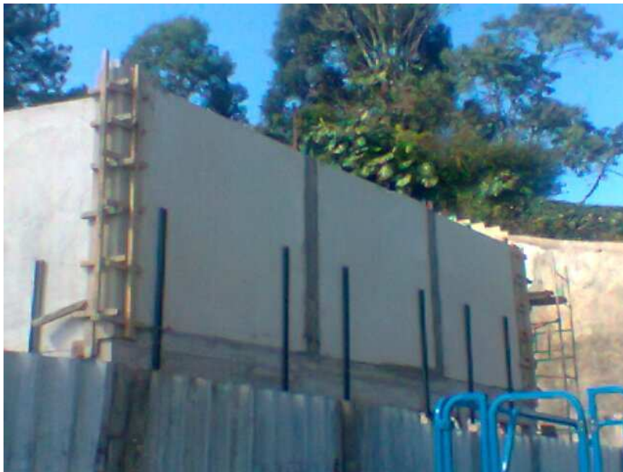
Figura 3-21 Junta entre os painéis pré-fabricados (Autor 2013)
