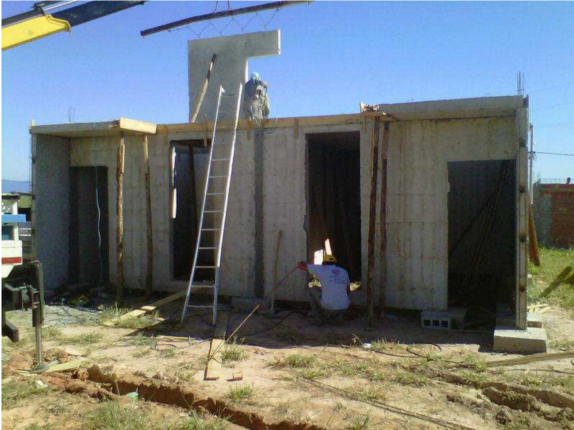
Figura 3-25 Equipe de execução (Autor 2013)
