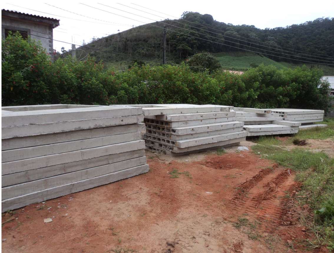
Figura 3-7 Painéis dispostos na localização da obra antes de ser montados (Autor 2012)
