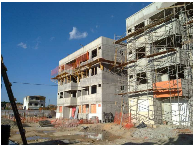
Figura 2-11 – Dois blocos concretados (Blanck, 2012)
