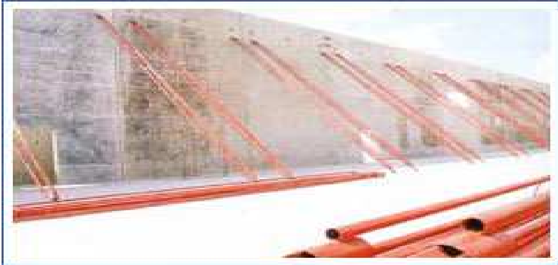
Figura 2-9 Escoras temporárias (Walter Torre Jr. 1993)
