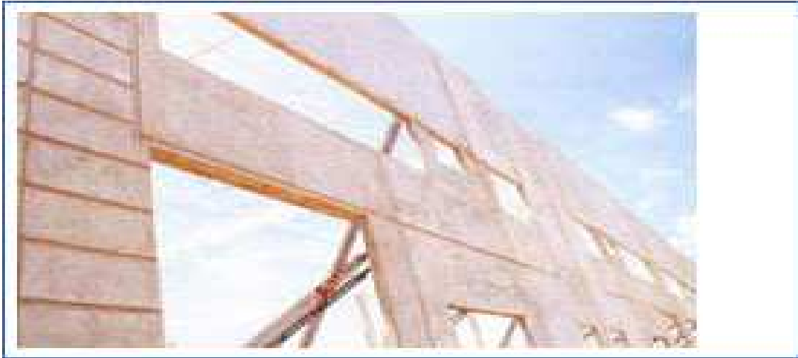
Figura 2-8 As escoras são fixadas até que a parede seja solidarizada ao piso ou à estrutura de lajes. (Torre Jr. 1993)
