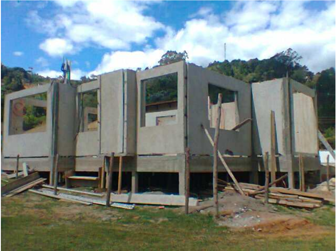
Figura 3-11 Painéis escorados ( Autor 2012)
