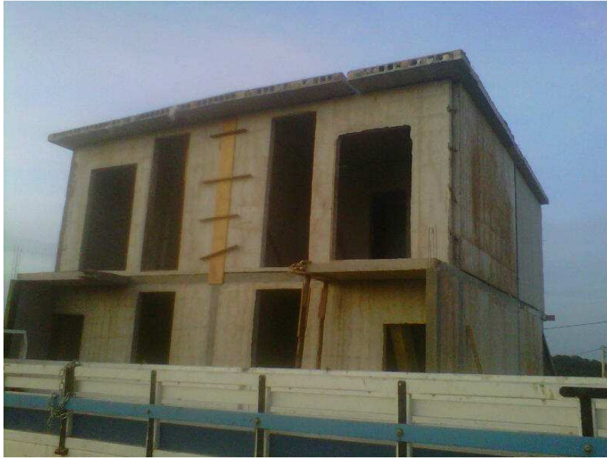
Figura 3-22 Painéis pré-fabricados de laje sendo montados (Autor 2013)
