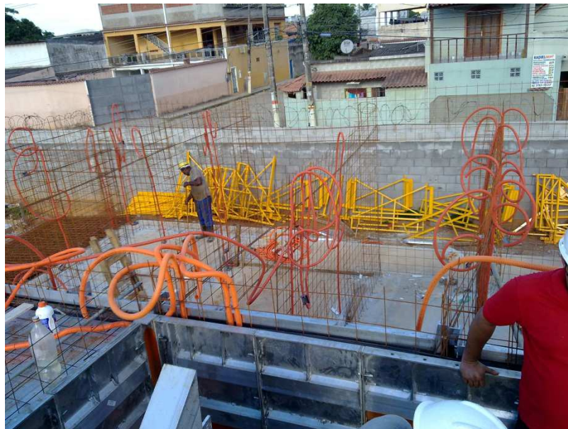
Figura 2-10 – Telas soldadas presas no radier (Blanck, 2012)
