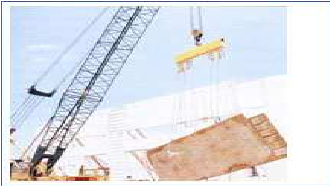
Figura 2-7 Após atingirem a resistência necessária, as paredes são levantadas por guindastes. (Walter Torre Jr. 1993)
