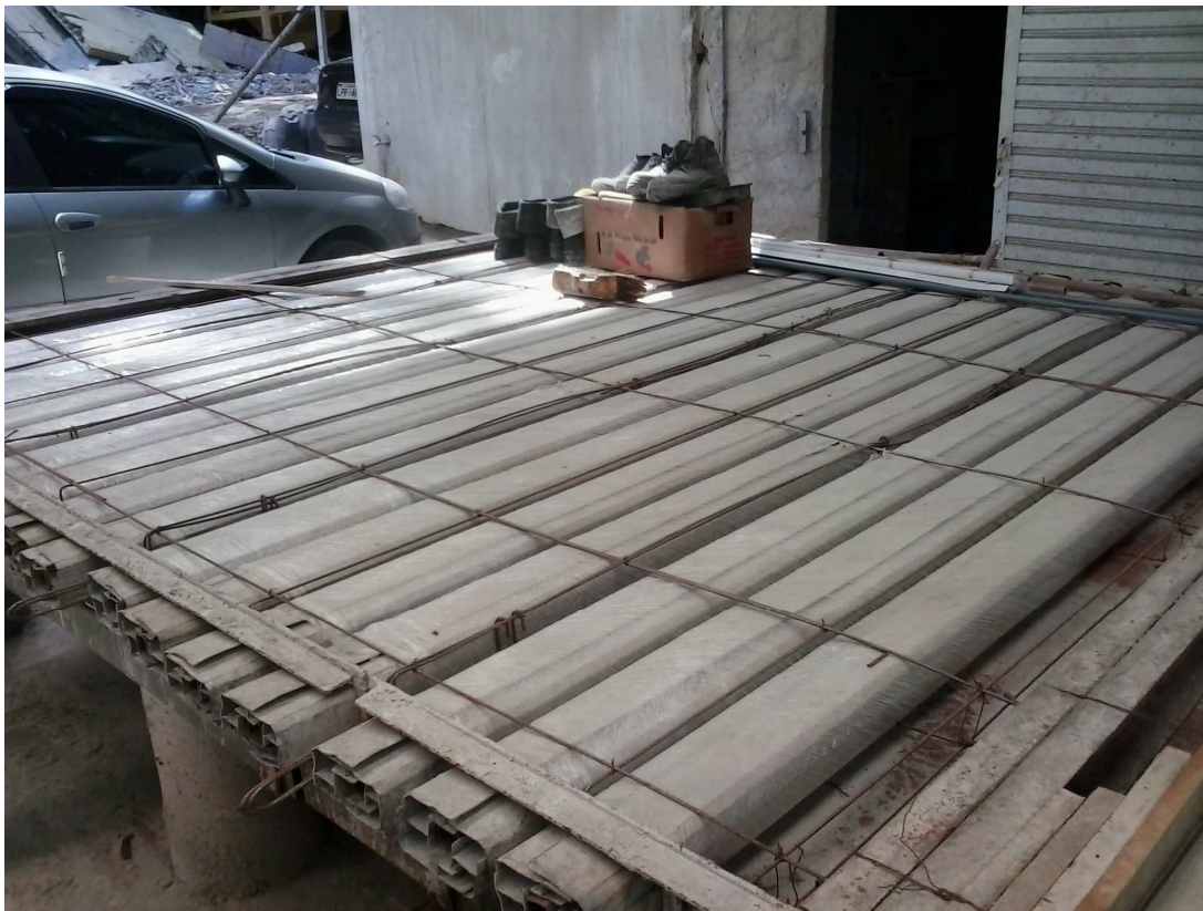
Figura 3-17 montagem dos Alvéolos em conjunto com a armação (Autor 2013)
