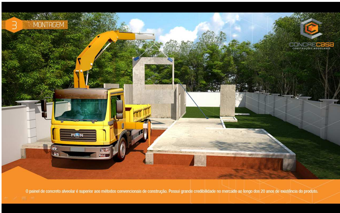
Figura 3-19 Ilustração da montagem dos painéis pré-fabricados (Concrecasa 2012)
