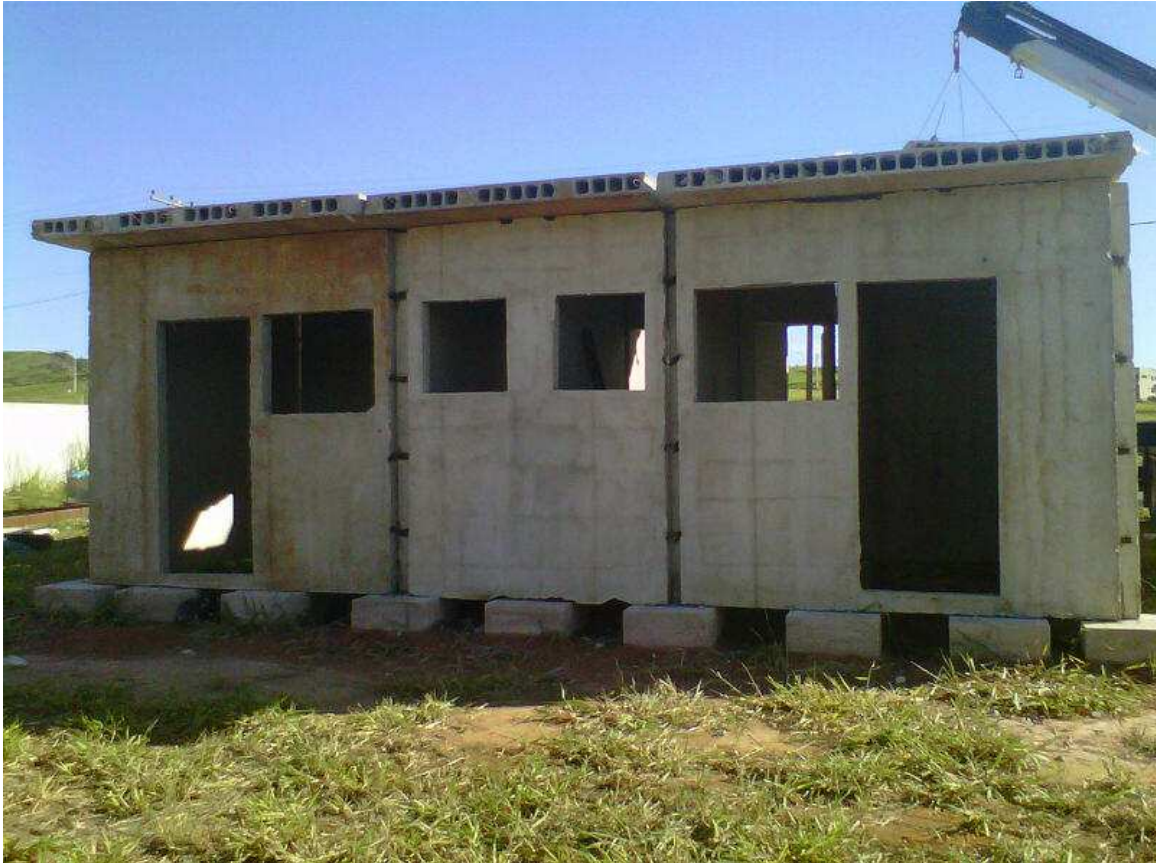
Figura 3-8 Montagem dos painéis de laje (Autor 2012)
