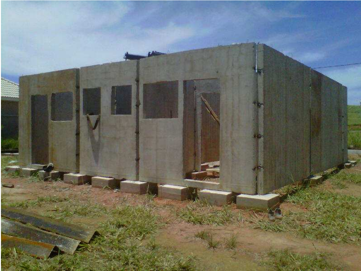
Figura 3-9 Detalhes da solda entre as armações dos painéis (Autor 2012)
