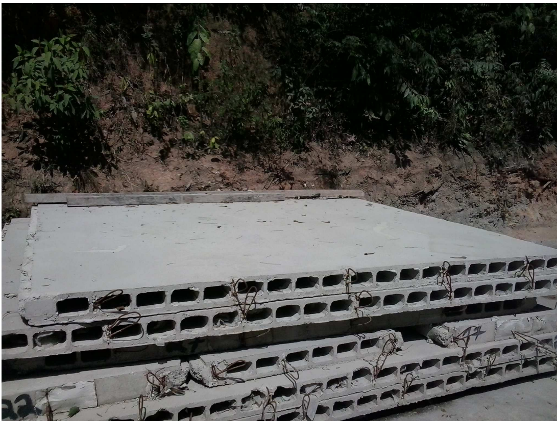
Figura 3-20 Painéis pré-fabricados armazenados no local de produção (Autor 2013)
