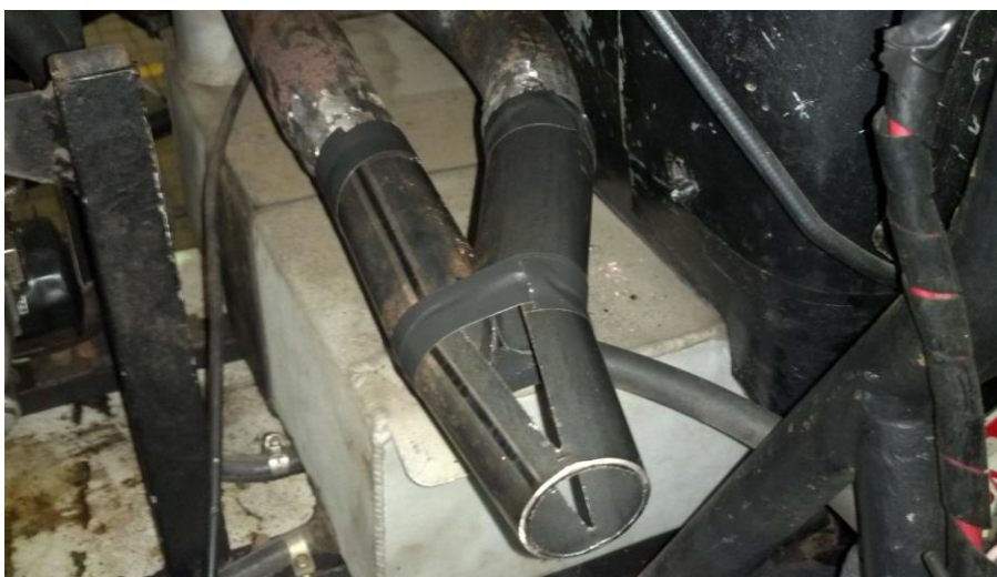
Figura 4.5.1- Posicionando os dutos
