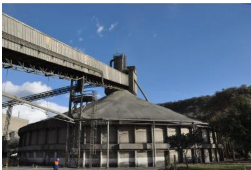
Figura 13 - Silo para armazenamento de clínquer.
