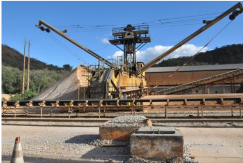
Figura 8 - Baía provida de equipamento homogeneizador de matéria-prima. (Fonte: Fotos retiradas pelo autor)
