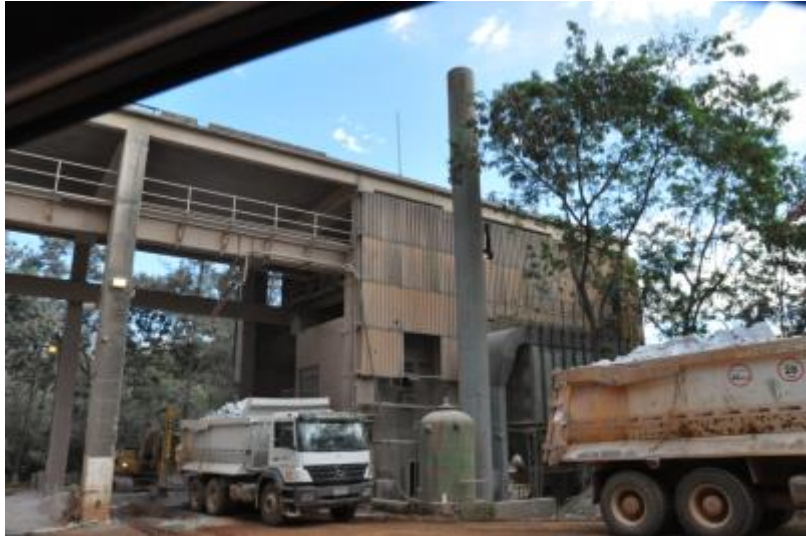
Figura 6 - Estação de britagem. (Fonte: Fotos retiradas pelo autor)
