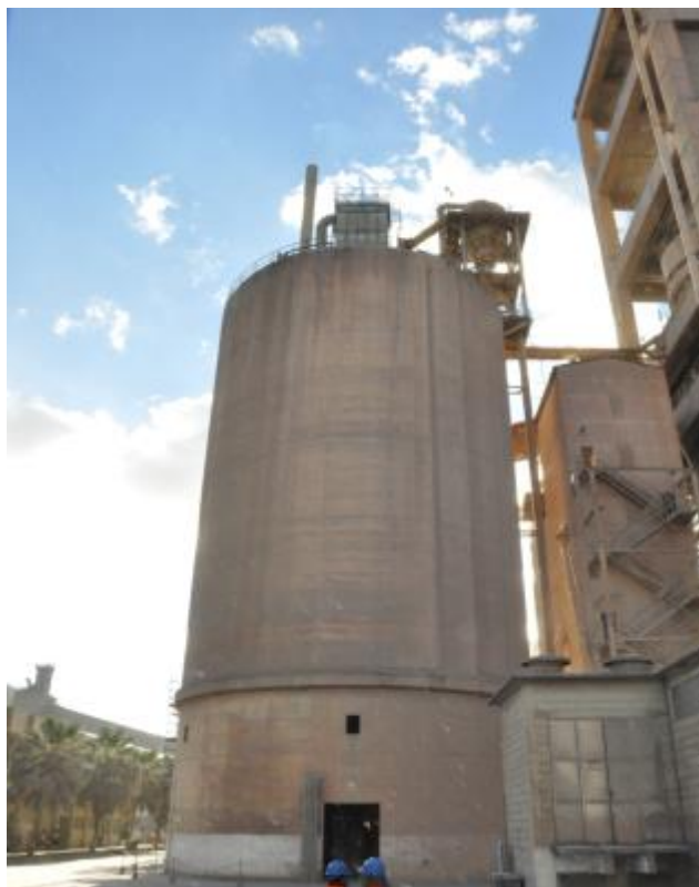
Figura 10 - Silos de homogeneização de farinha.
