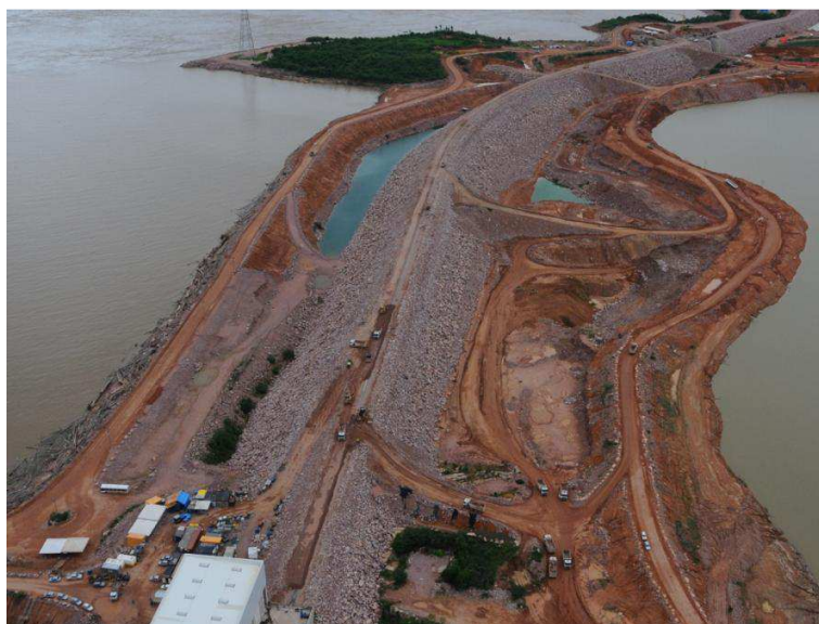
3.33: Construção da BENA - UHE Jirau: Acessos pelo talude de montante e jusante vistos a partir da margem esquerda - Dezembro/2012 (RAMALHO et al., 2013)
