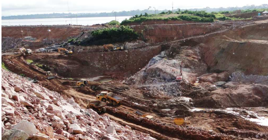
Figura 3.16: Escavação da fundação da barragem - UHE Jirau (RAMALHO et al., 2013)
