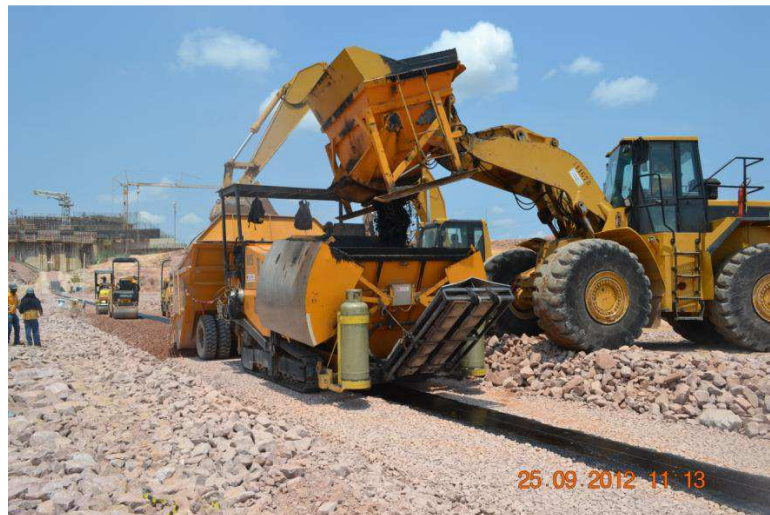
Figura 3.26: Abastecimento dos silos da máquina distribuidora - UHE Jirau (RAMALHO et al., 2013)
