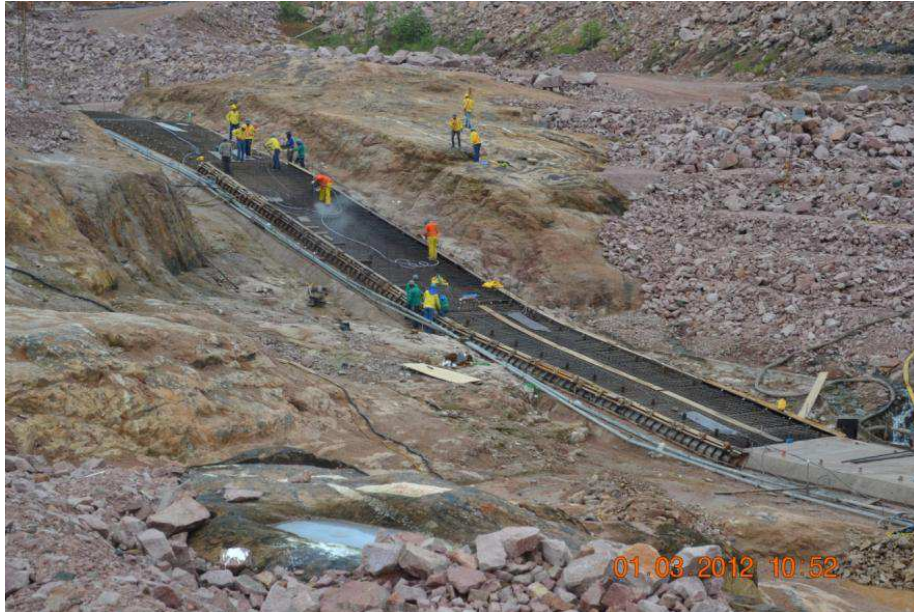
Figura 3.18: Etapa de Execução da Laje de Concreto (Plinto) - UHE Jirau (RAMALHO et al., 2013)
