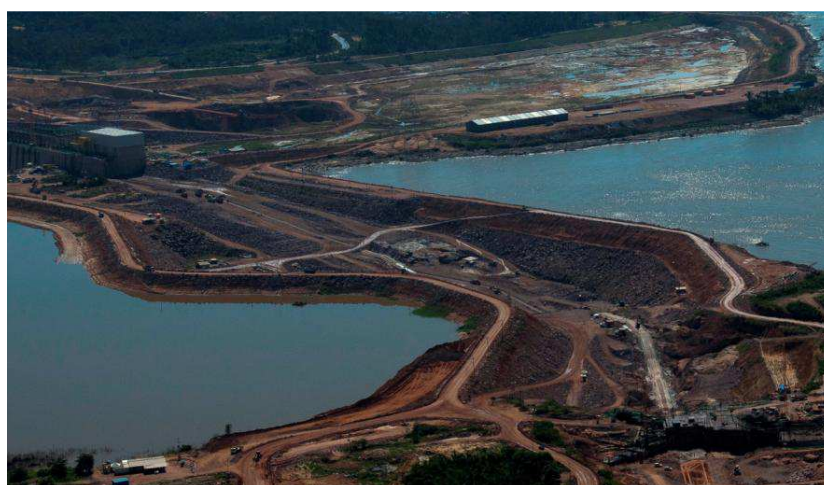
Figura 3.30: Construção da BENA - UHE Jirau: Ensecadeira de Montante e Jusante, Plinto da margem direita e Casa de Força na margem esquerda - Junho/2012 (RAMALHO et al., 2013)
