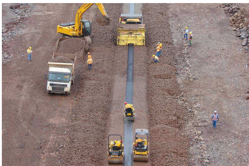
Figura 2.20: Fase mecânica – Lançamento e compactação simultânea do núcleo asfáltico e da transição fina – UHE Foz do Chapecó (Camargo Corrêa, 2010)
