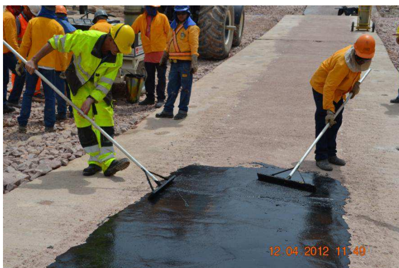
Figura 3.20: Aplicação do Mástique Asfáltico - UHE Jirau (RAMALHO et al., 2013)
