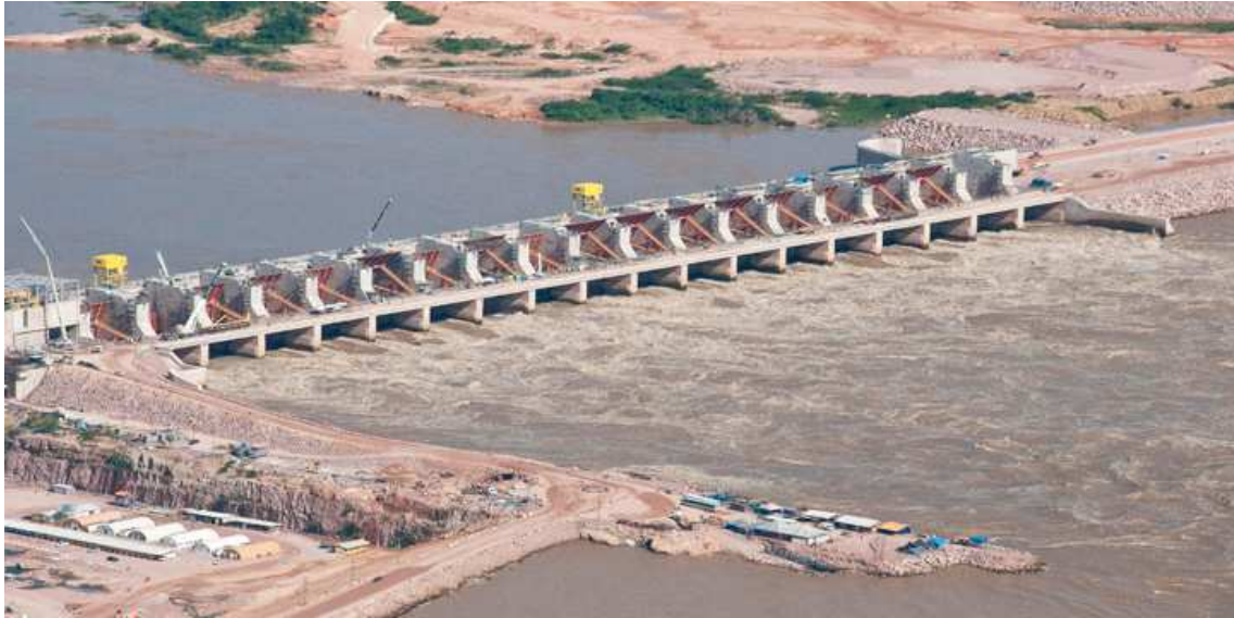
Figura 3.3: Vertedouro UHE Jirau - vista de jusante para montante (Camargo Corrêa, 2012)
