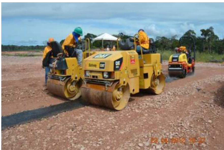
Figura 3.12: Compactação do núcleo e da transição da pista experimental 1 - UHE Jirau (RAMALHO et al.,2013)
