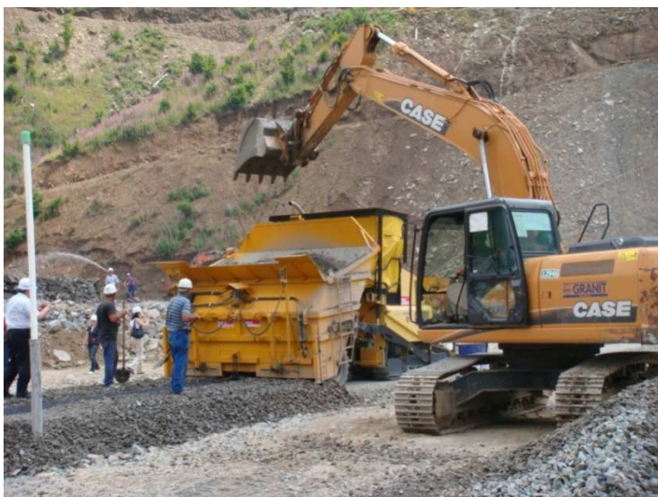
Figura 2.10: Lançamento simultâneo da transição fina e do concreto asfáltico (KOLO VEIDEKKE)
