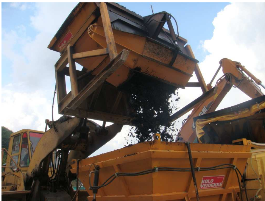
Figura 2.17: Recarregamento do Silo de Concreto Asfáltico (KOLO VEIDEKKE, 2009)
