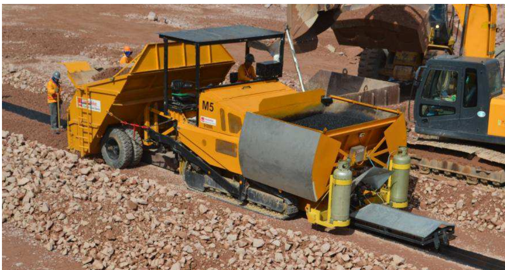
Figura 3.24: Máquina vibro acabadora utilizada na UHE Jirau (RAMALHO et al., 2013)
