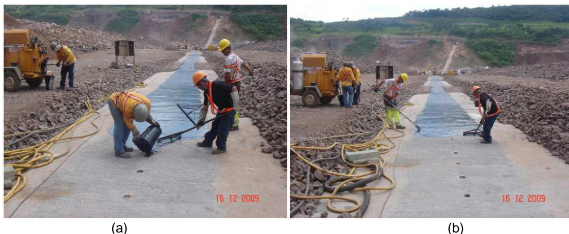
(a) (b) Figura 2.19: Aplicação do Mástique: a) Detalhes do Espalhamento, b) Camada de Mástique Aplicada (GUIMARÃES,2012).
