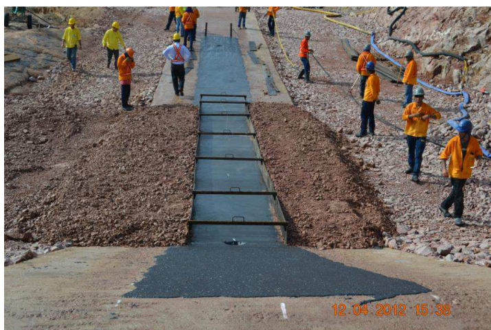
Figura 3.21: Instalação de formas - UHE Jirau (RAMALHO et al., 2013)
