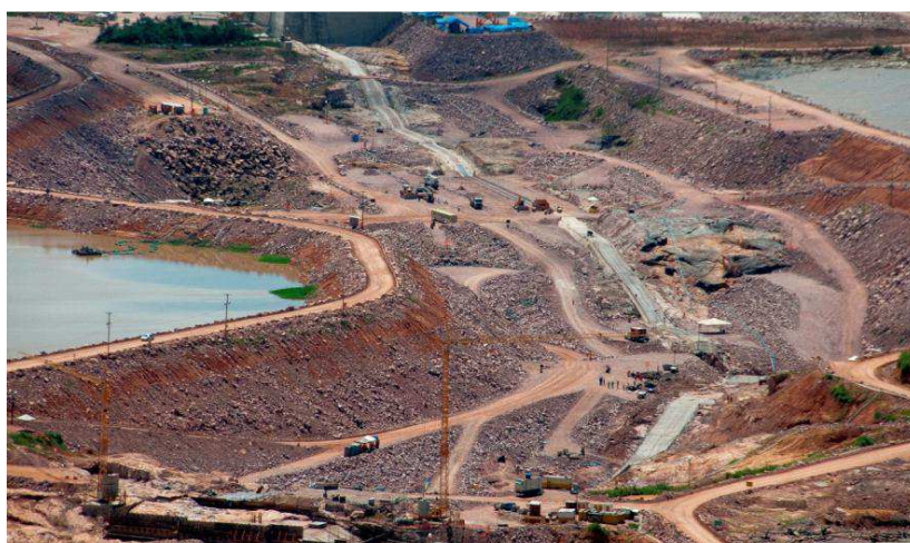
Figura 3.29: Construção da BENA - UHE Jirau: Construção do Plinto - Abril/2012 (RAMALHO et al., 2013)
