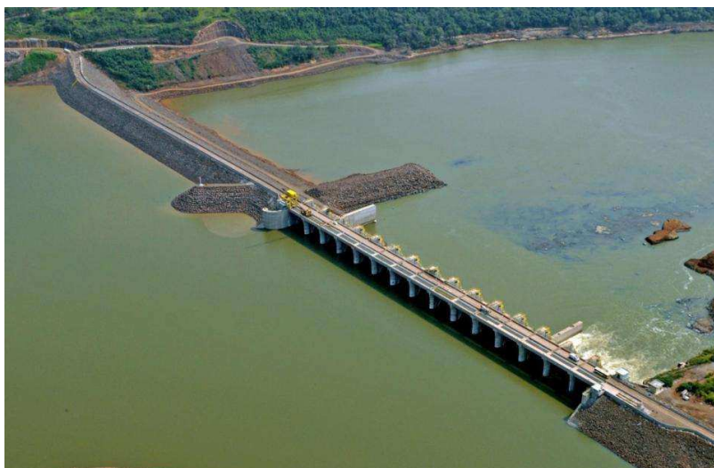
Figura 2.6: UHE Foz do Chapecó, vista aérea de montante (Camargo Corrêa, 2010)
