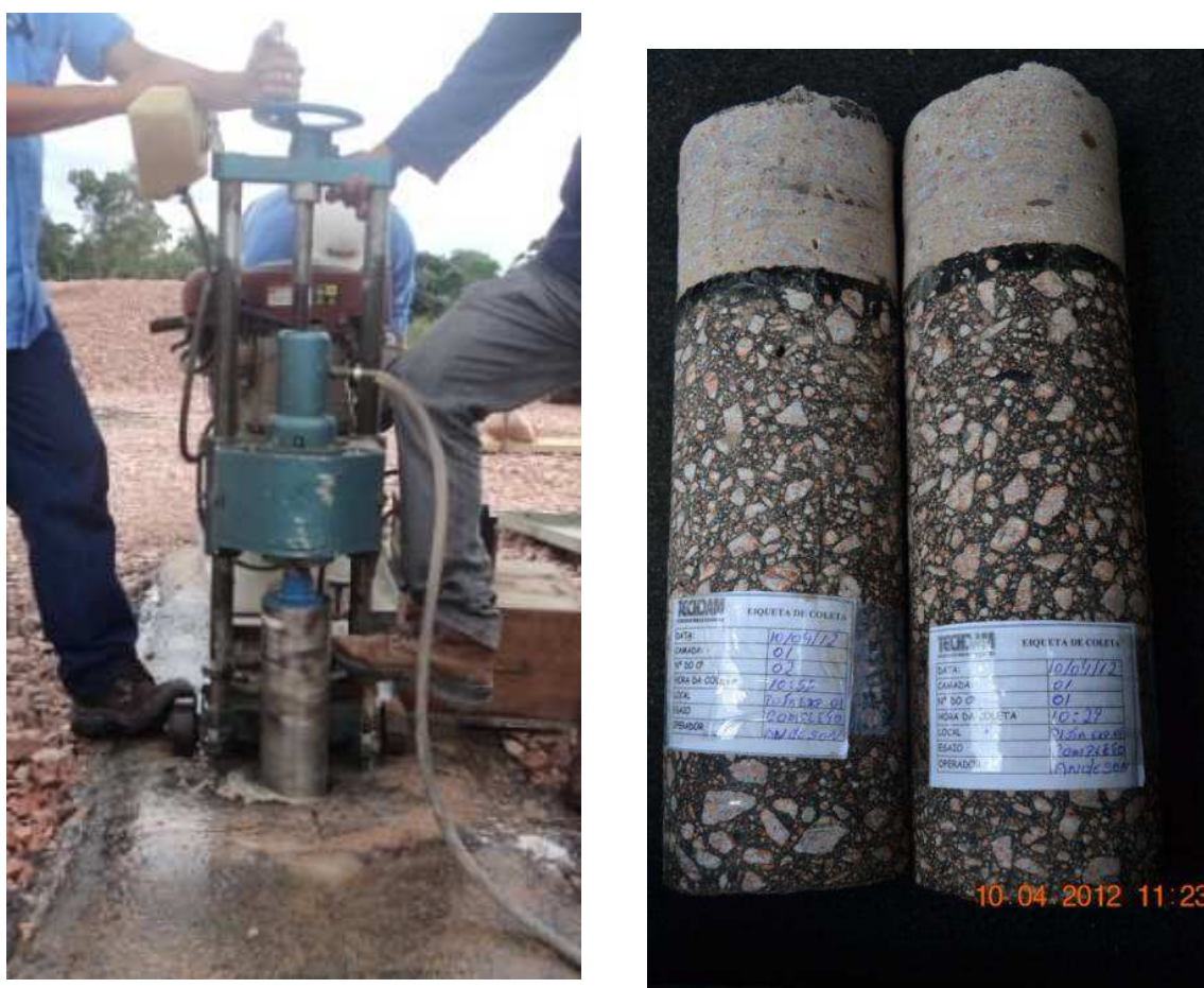
Figura 3.42: Extração de Testemunhos do Núcleo de Concreto Asfáltico - UHE Jirau (RAMALHO et al., 2013)
