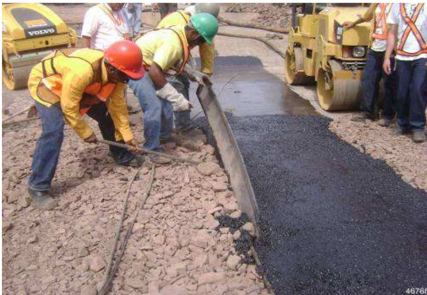
Figura 3.23: Remoção das formas no trecho manual do núcleo - UHE Jirau (RAMALHO et al., 2013)
