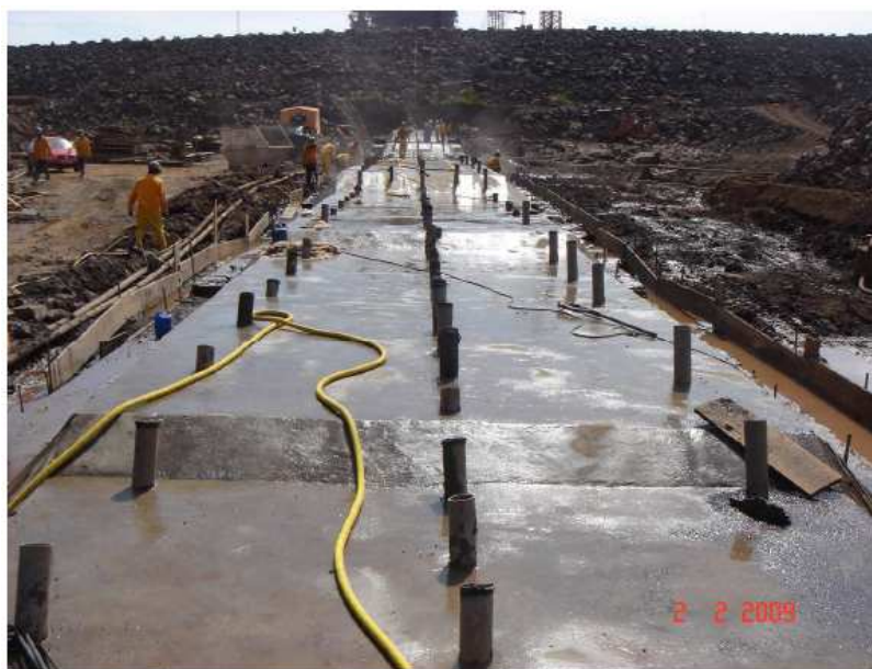
Figura 2.18: Plinto com furos de injeção - UHE Foz do Chapecó (GUIMARÃES, 2012)
