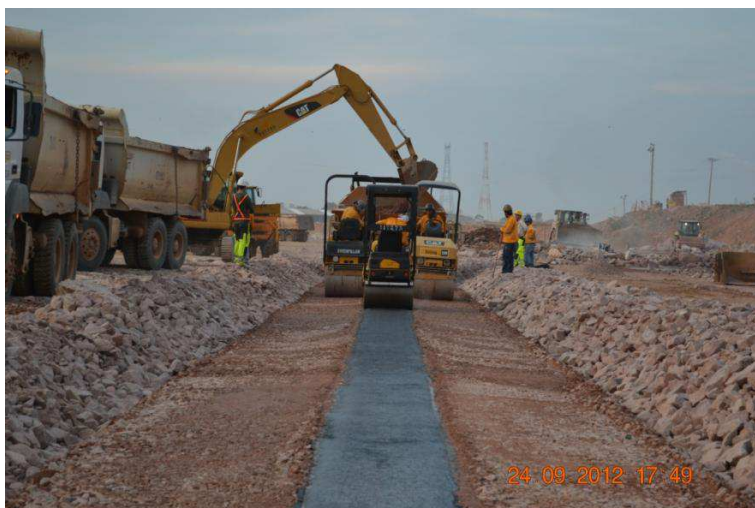
Figura 3.28: Compactação simultânea do núcleo asfáltico e da transição fina - UHE Jirau (RAMALHO et al., 2013)
