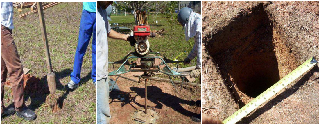
Figura 3.17– Furo realizado para as estaca (GUIMARÃES, 2007).
