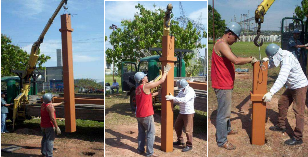
Figura 3.18 – Manuseio e instalação da estaca teste no furo (GUIMARÃES, 2007).
