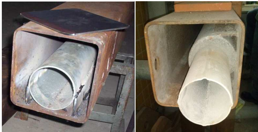
Figura 3.14 – Tubo de inclinômetro instalado na estaca 2
