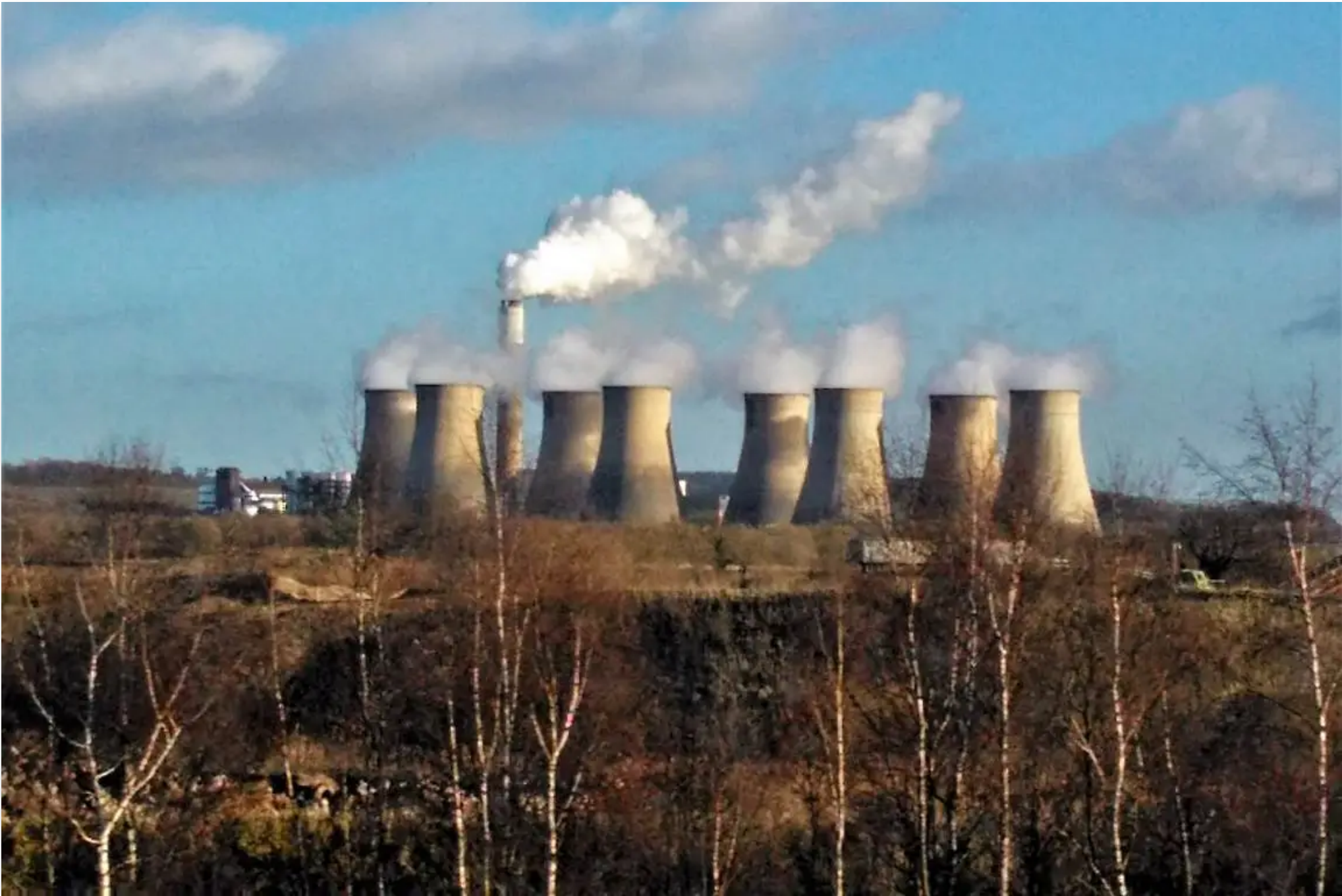
Usina termelétrica na Inglaterra. Foto: Carlos Eduardo Young.
