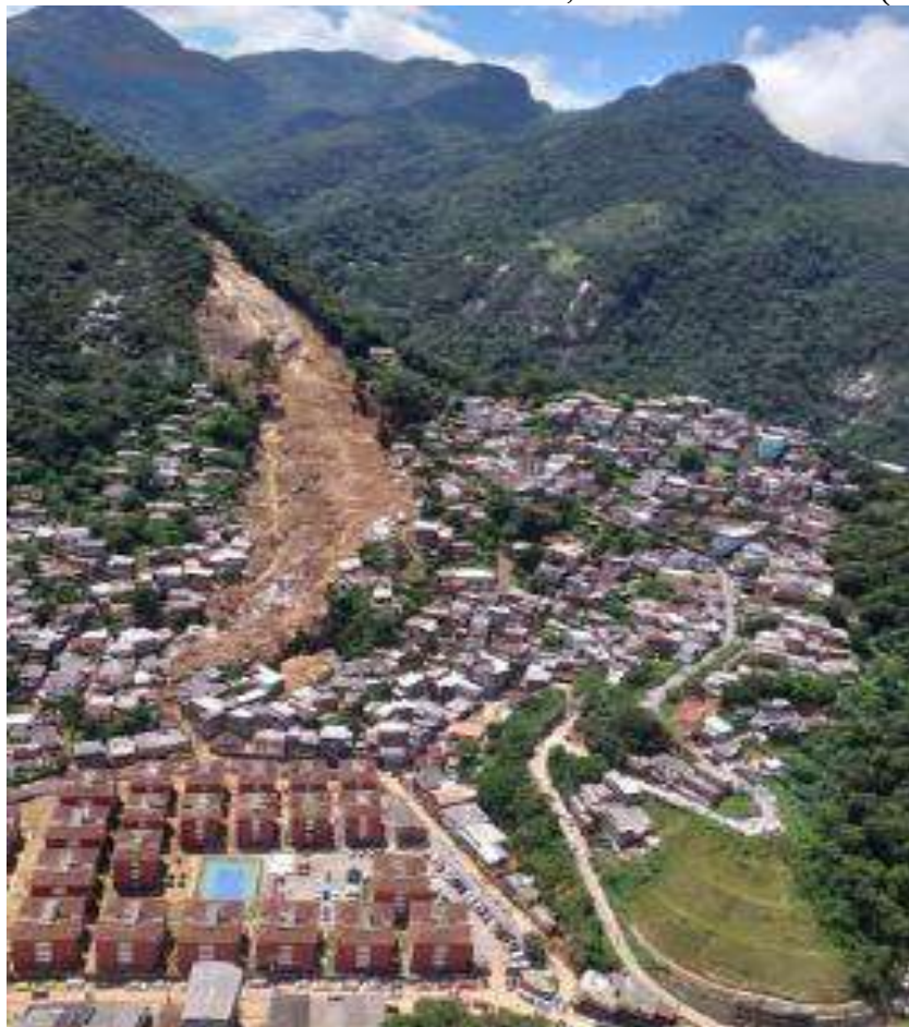
Figura 13 – Deslizamento raso na Servidão Frei Leão, Alto da Serra em 2022 (1º Distrito).
