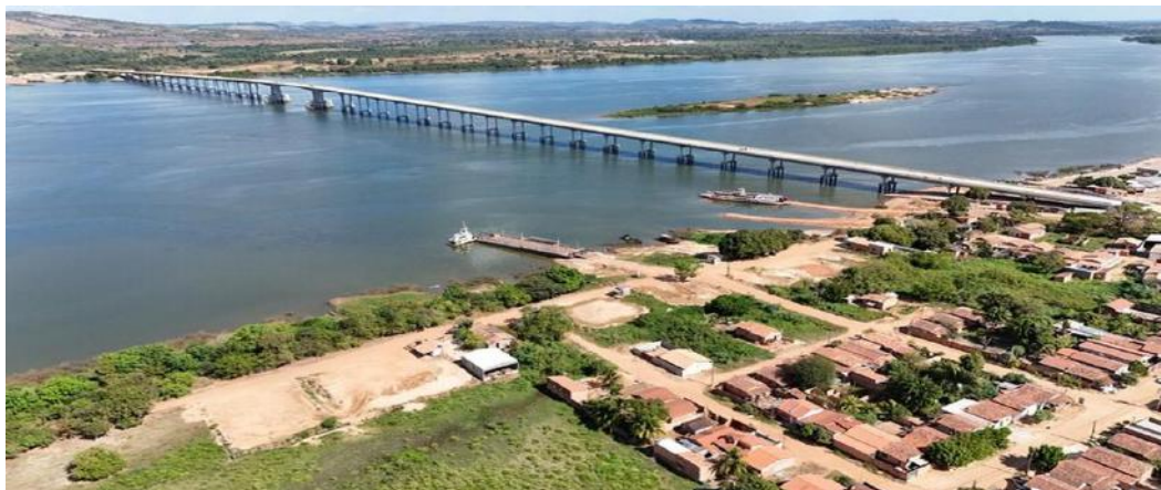
Imagem 2 – Ponte inutilizada por falta de acessos
