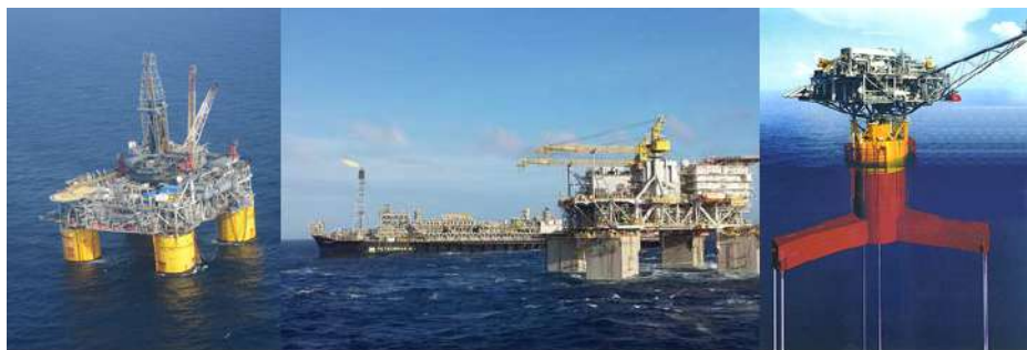
Figura 1.2 Plataformas TLWP em Operação.
