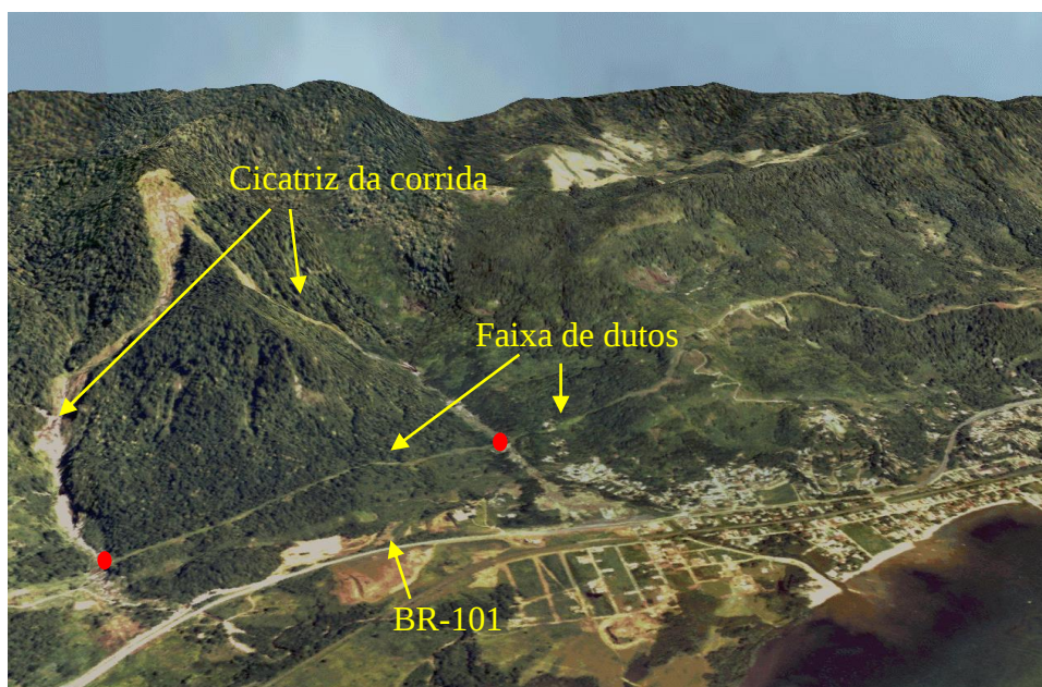
Figura 1-1 - Imagem de modelo digital de corrida de detritos atingindo faixa de dutos (RABACO, 2005)
